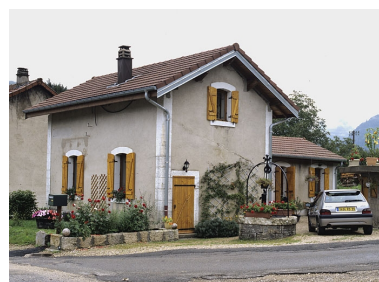
Façades nord et ouest. Phot. Yves Sancey IVR43_20043900491XA
