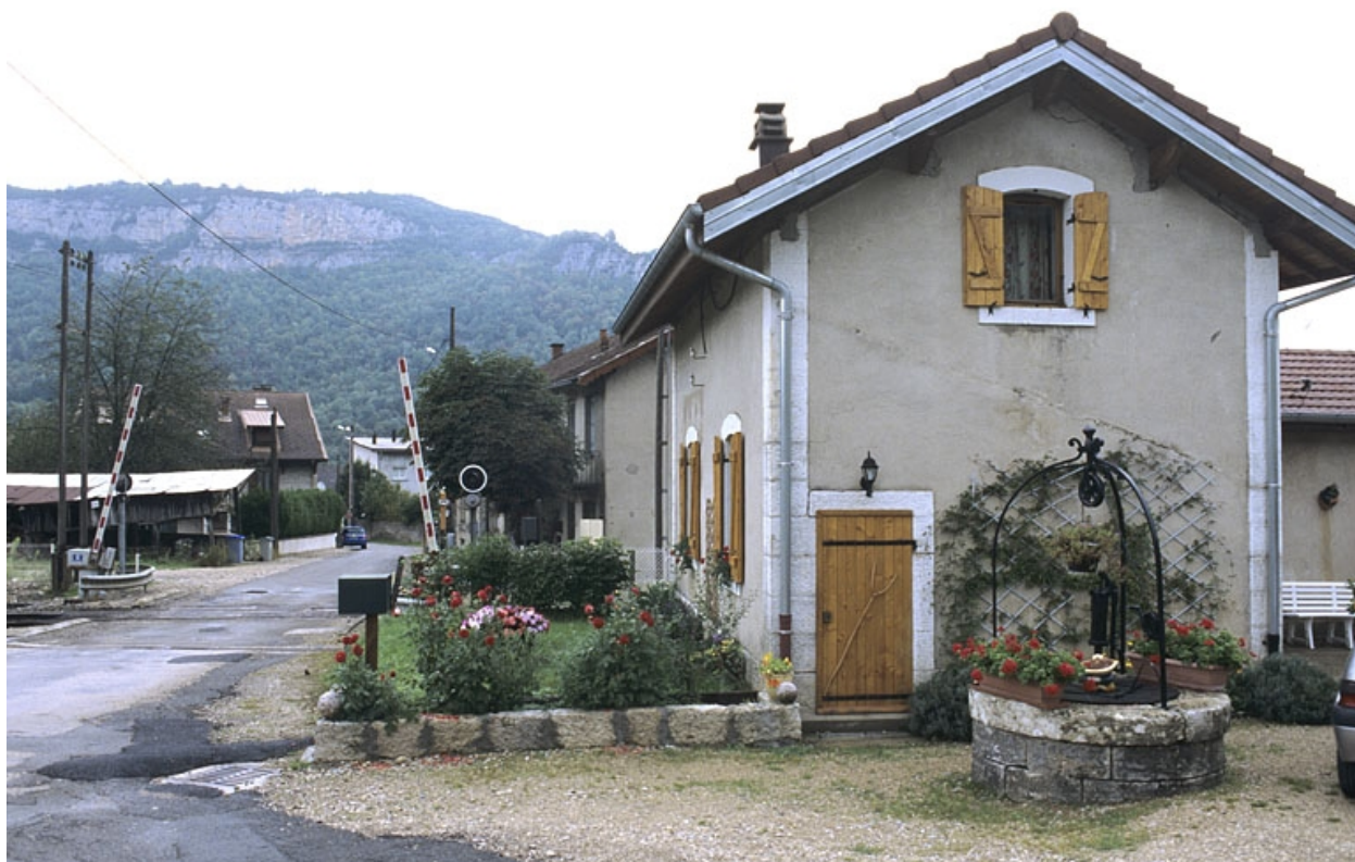
Passage à niveau et façade ouest.
