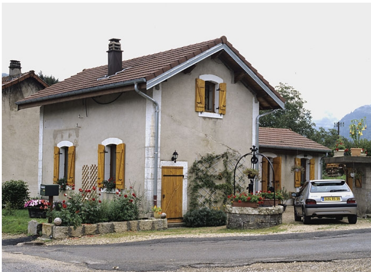
Façades nord et ouest.
