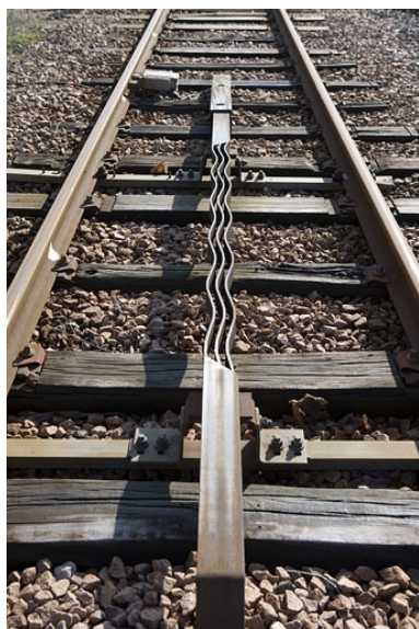
Vue d'ensemble. Phot. Yves Sancey IVR43_20073900047NUCA
