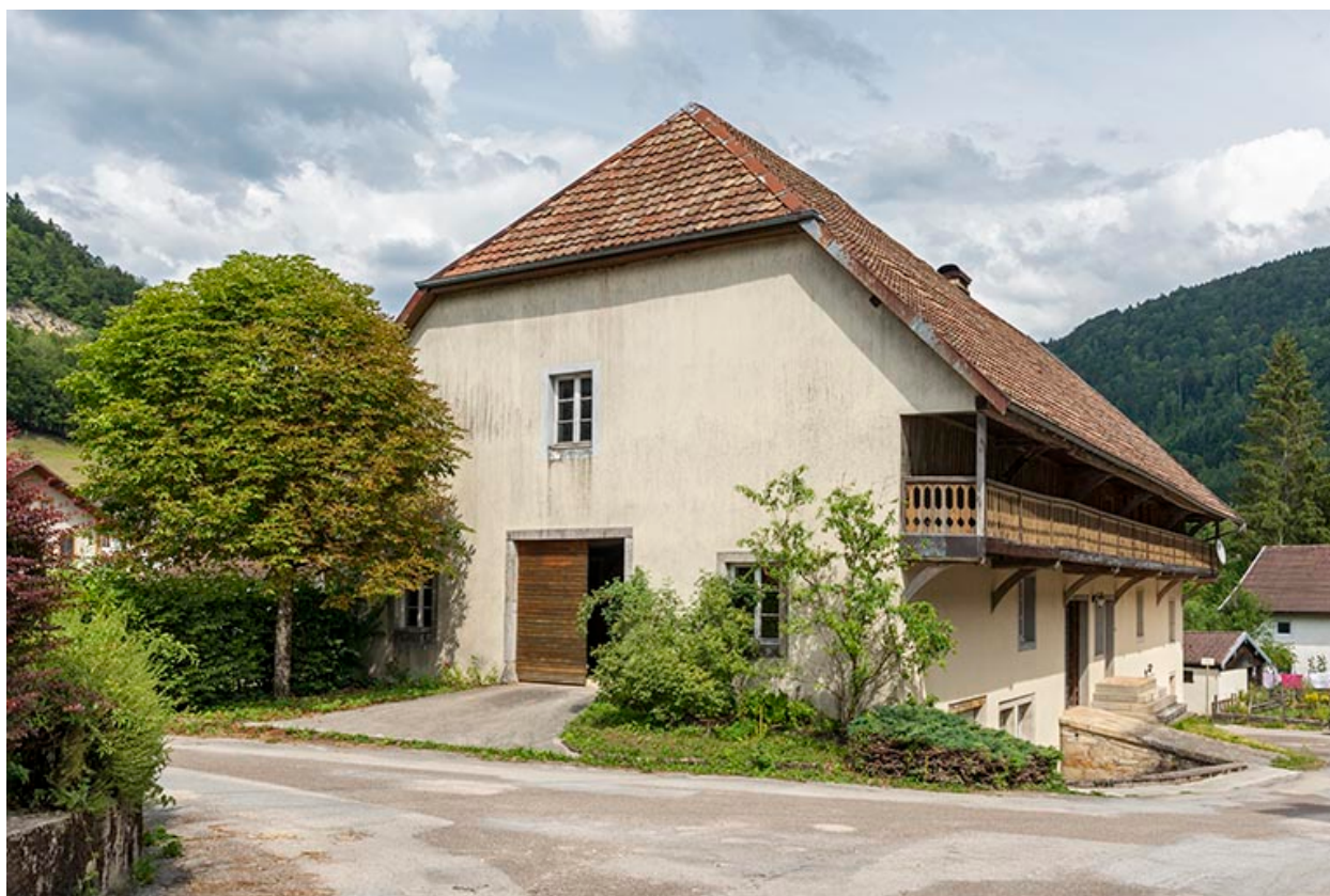
Ferme : façades antérieure et latérale gauche.
