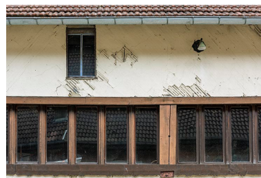
Forge (façade ouest) : fenêtres mutiples et lattis de plâtre. Phot. Sonia Dourlot IVR43_20192500631NUC4A
