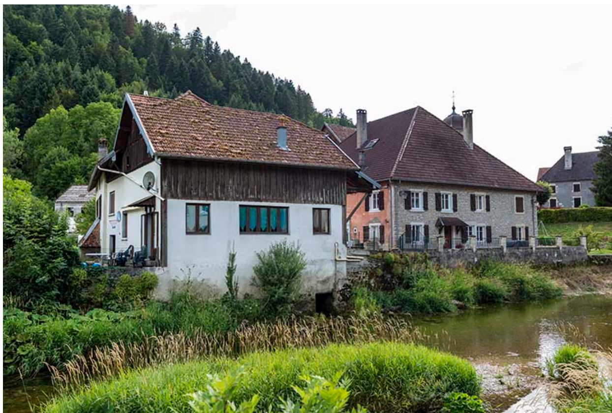
Forge et maison : façade nord (côté Dessoubre).
