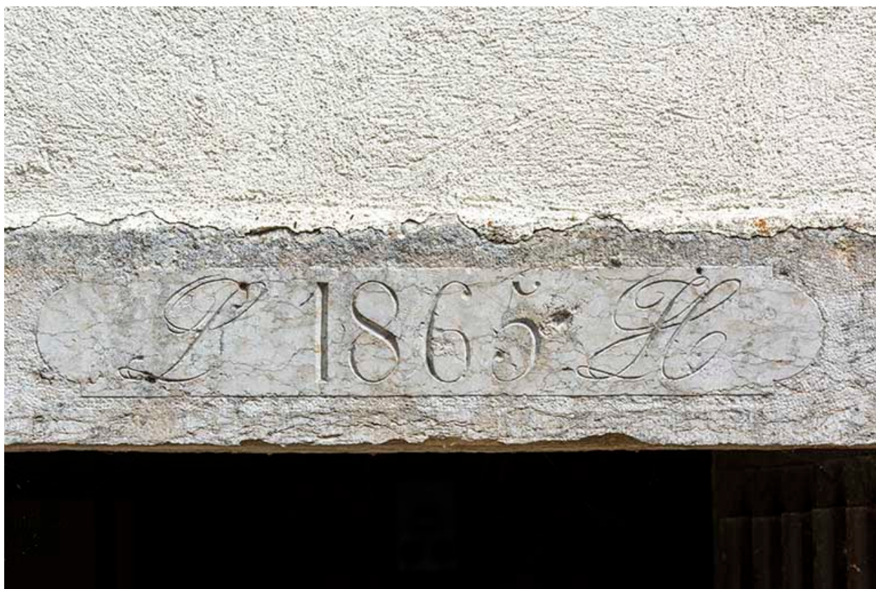
Forge (façade ouest) : linteau daté.
