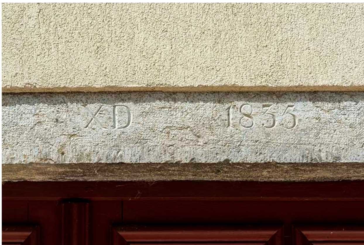
Ferme : linteau daté sur la façade antérieure.
