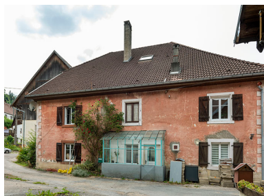
Maison : façade est (côté cour). Phot. Sonia Dourlot IVR43_20192500633NUC4A
