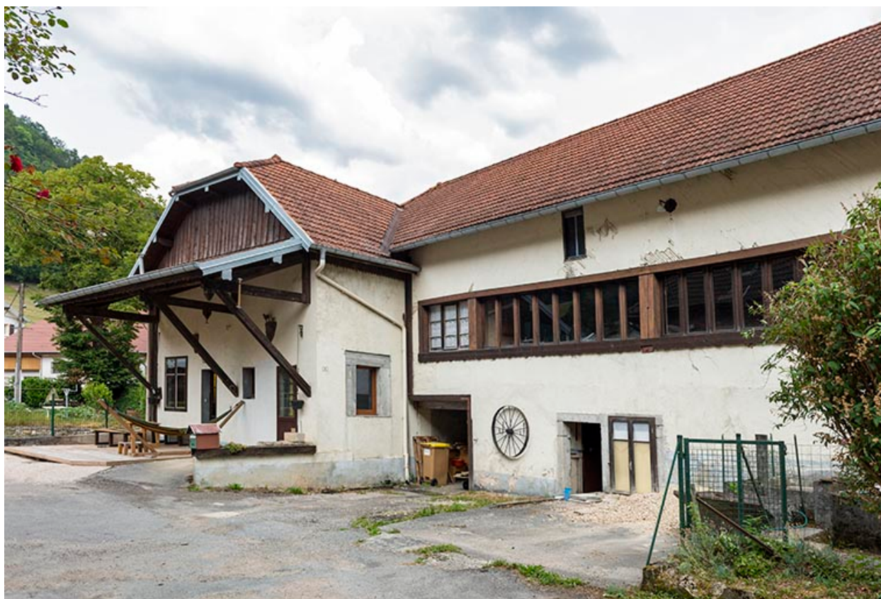
Forge : façade ouest (côté cour).
