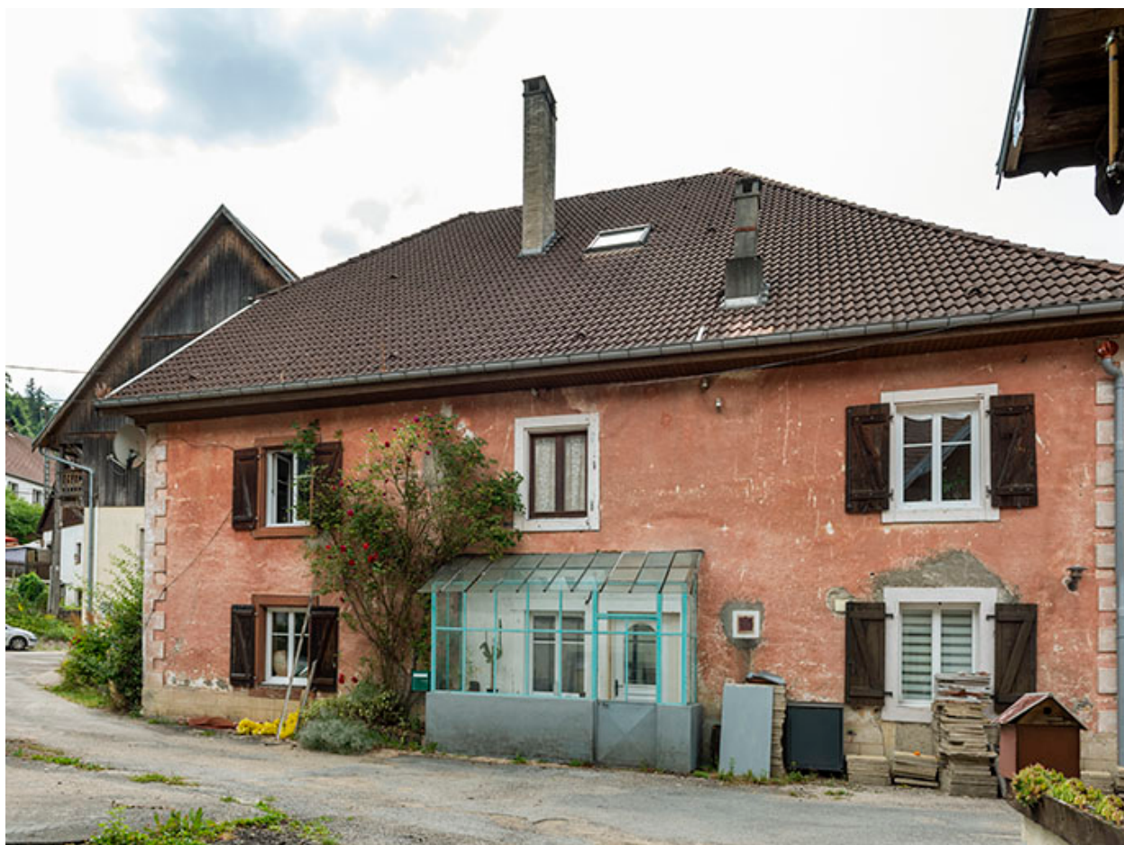
Maison : façade est (côté cour).
