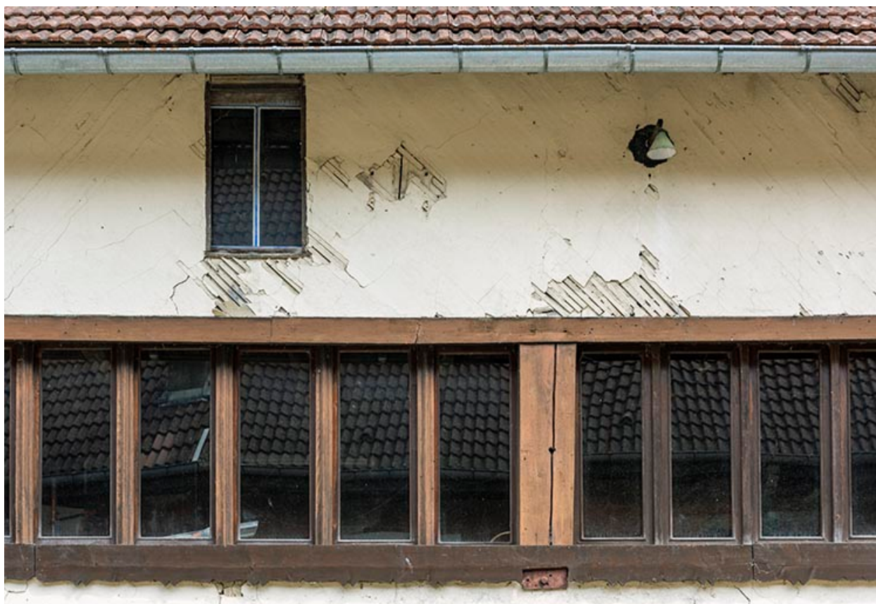
Forge (façade ouest) : fenêtres multiples et latis de plâtre.
