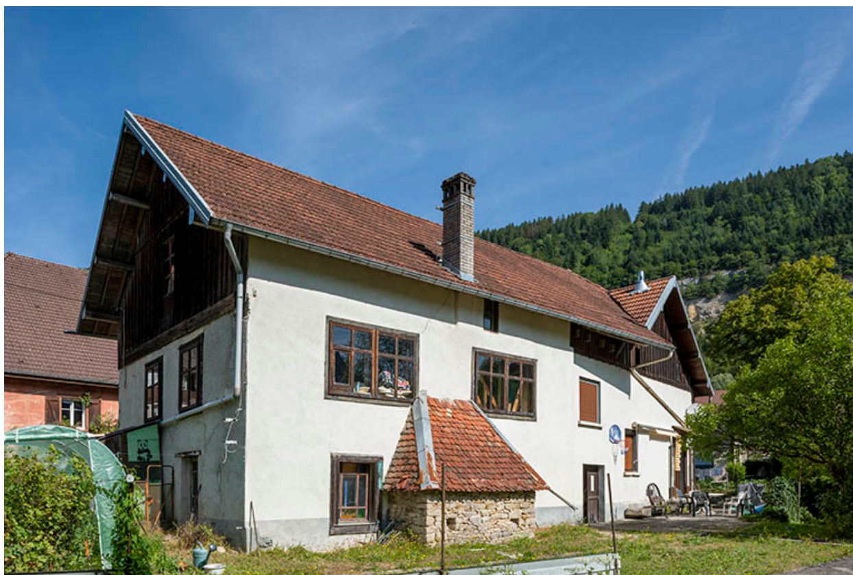
Forge : façades sud et est.
