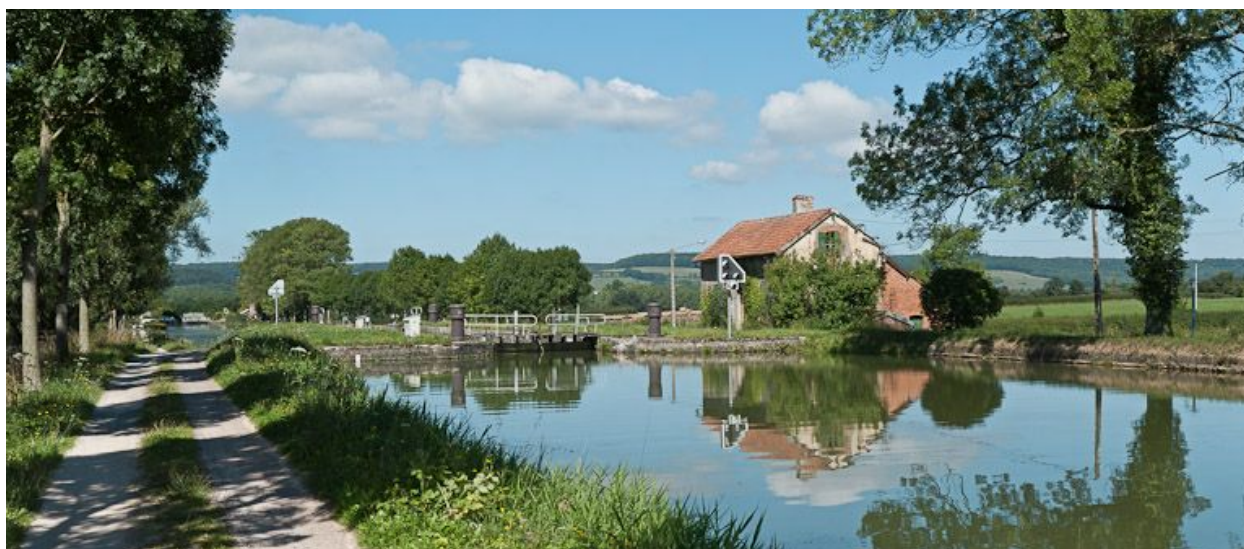
Vue du site d'écluse depuis l'amont.
