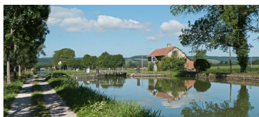
Vue du site d'écluse depuis l'amont. Phot. Pierre-Marie Barbe-Richaud IVR26_20112103679NUC4AQ
