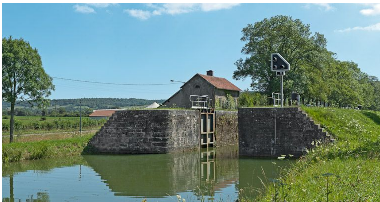
Vue du site d'écluse depuis l'aval.
