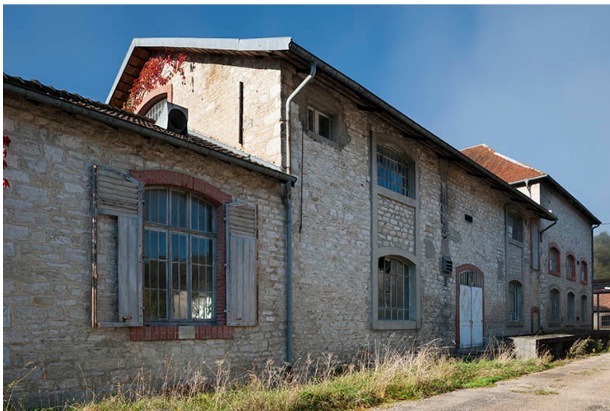
Façades est de l'atelier principal.
