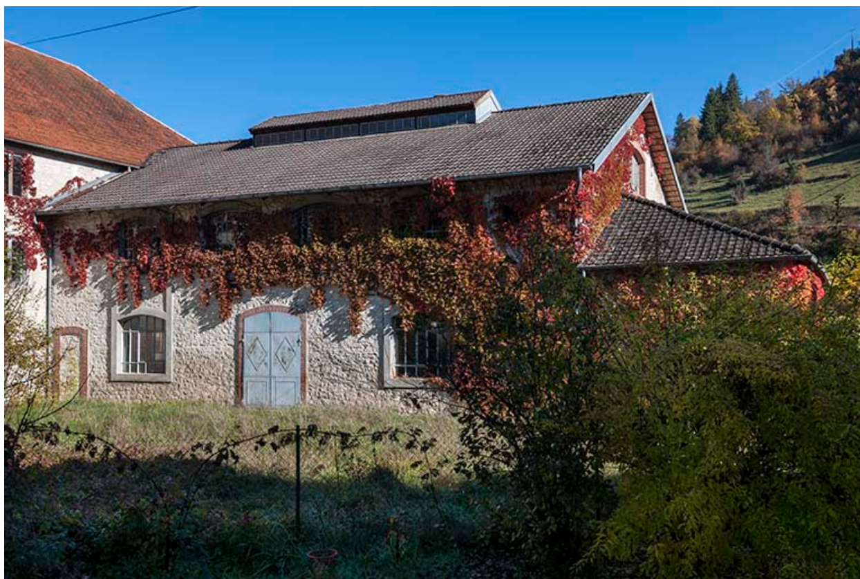
Bâtiment de la distillerie (salle des alambics ?).
