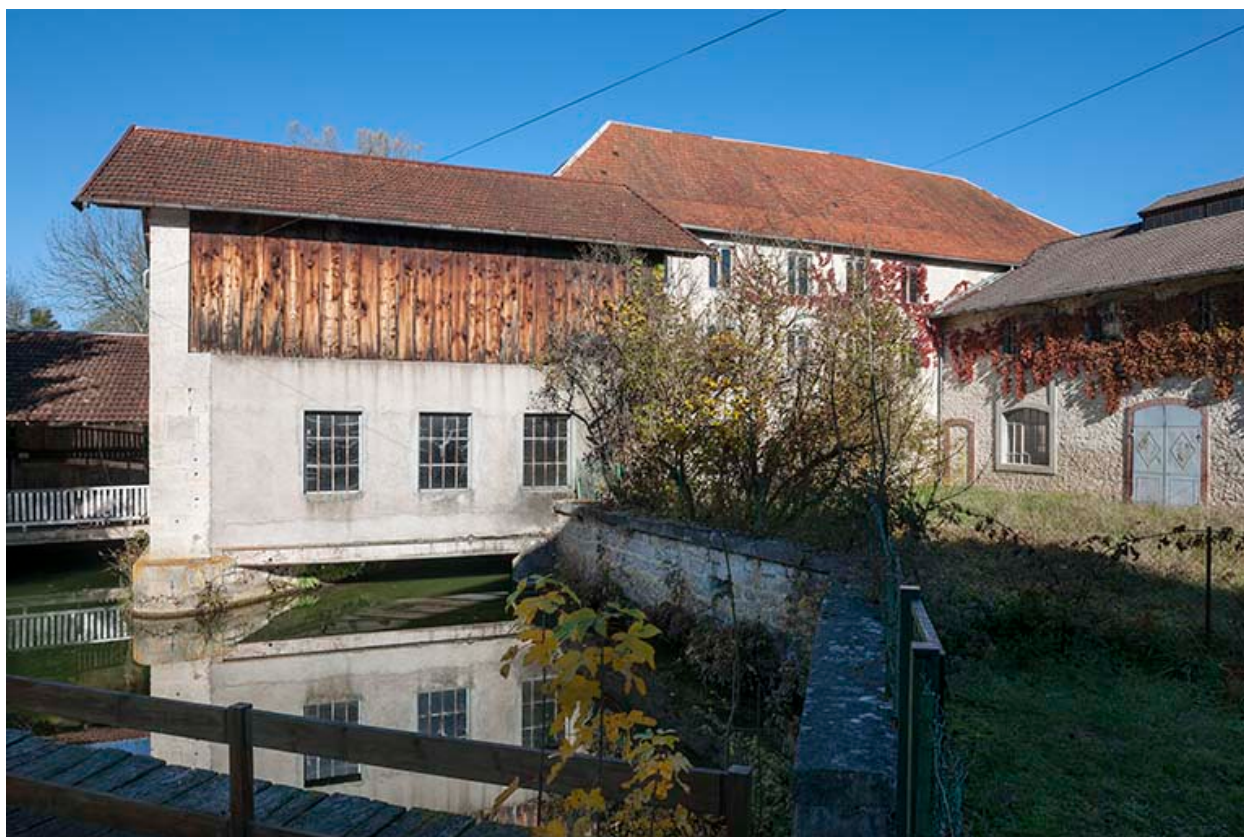
Bâtiment d'eau et atelier de fabrication.
