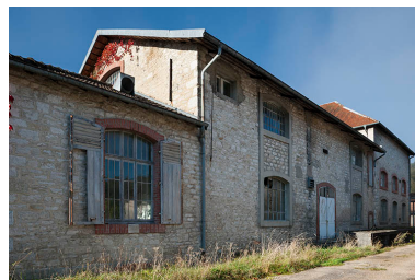
Façades est de l'atelier principal. Phot. Jérôme Mongreville IVR43_20152502510NUC4A
