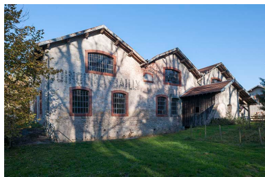
Ateliers ouest vus de trois quarts droite. Phot. Jérôme Mongreville IVR43_20152502521NUC4A
