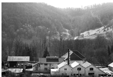
Vue plongeante depuis le nord en 2000. Phot. Jérôme Mongreville IVR43_20002500125X
