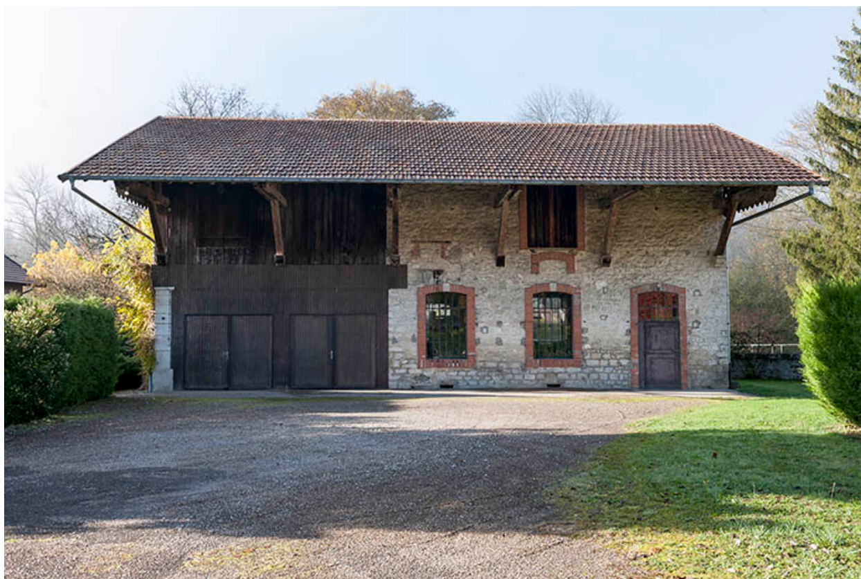
Entrepôt industriel. Face est.
