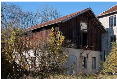
Bâtiment d'eau. Phot. Jérôme Mongreville IVR43_20152502512NUC4A
