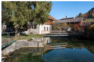
Canal d'aménée. Phot. Jérôme Mongreville IVR43_20152502514NUC4A
