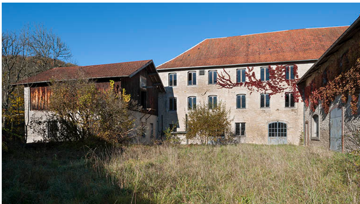
Façade sud de l'atelier.
