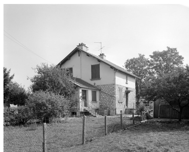
Face postérieure et face latérale gauche. Phot. Yves Sancey IVR43_19893900488X
