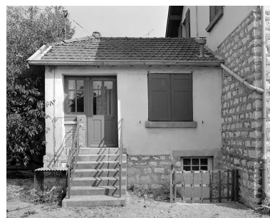
Face latérale gauche, la cuisine. Phot. Yves Sancey IVR43_19893900489X
