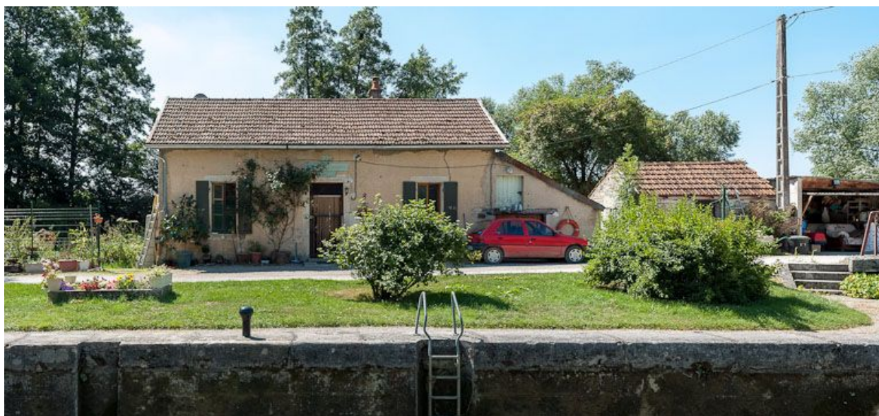
Maison éclusière, vue de face.
