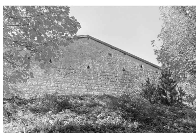
Face nord-est. Phot. Jérôme Mongreville IVR43_19963901358X
