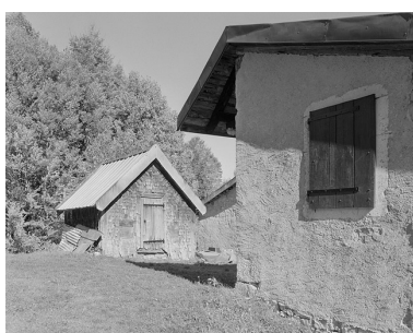
Le grenier fort. Phot. Jérôme Mongreville IVR43_19963901351X
