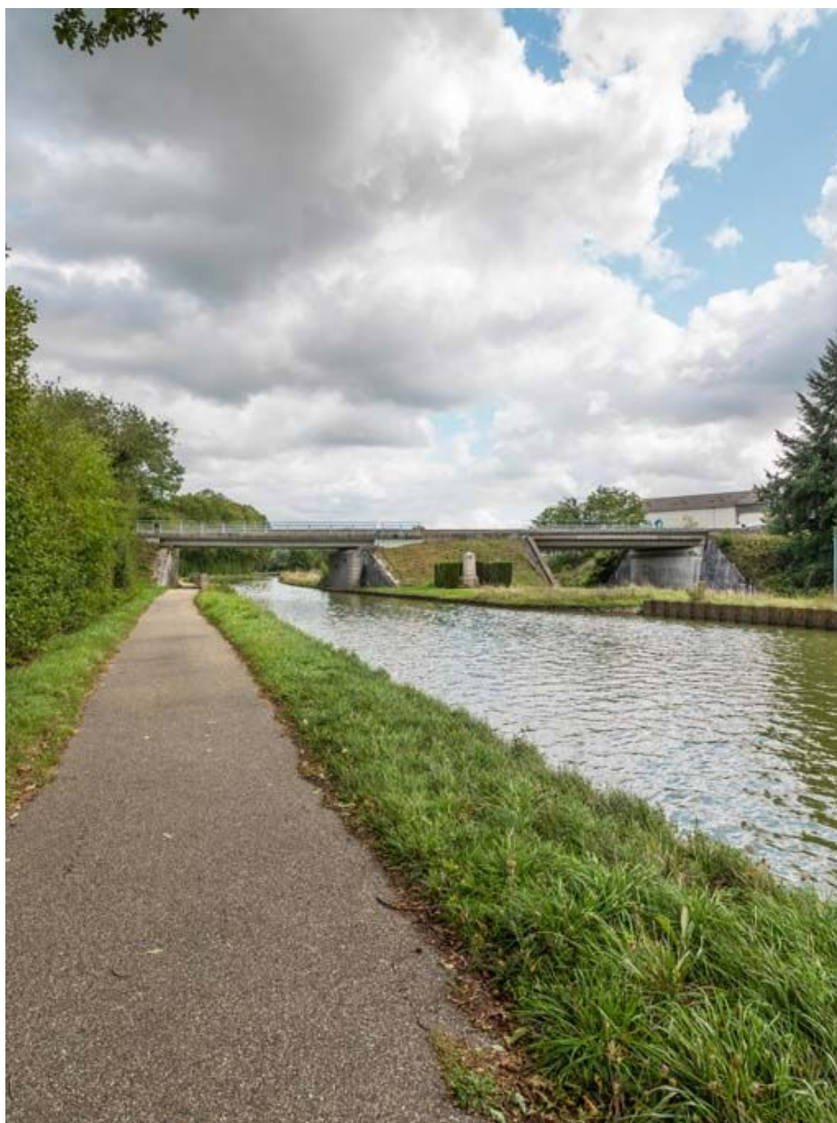
Vue d'ensemble du pont.
