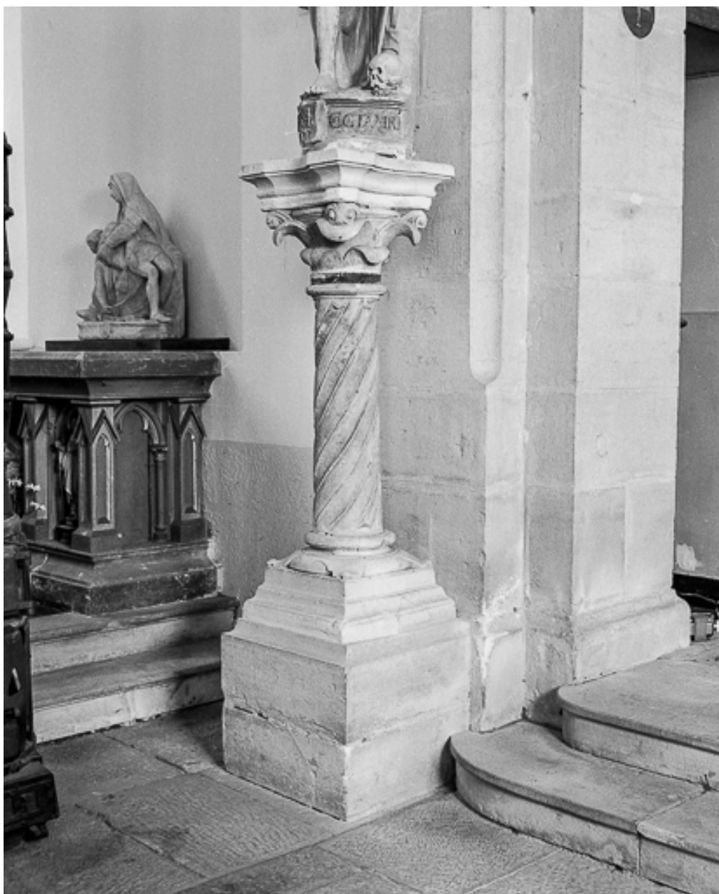
Détail de la colonne.
