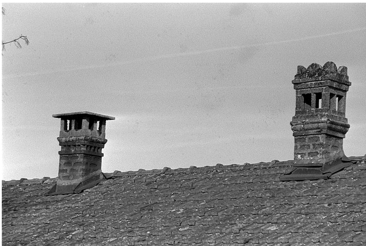
Souches des cheminées du logement.
