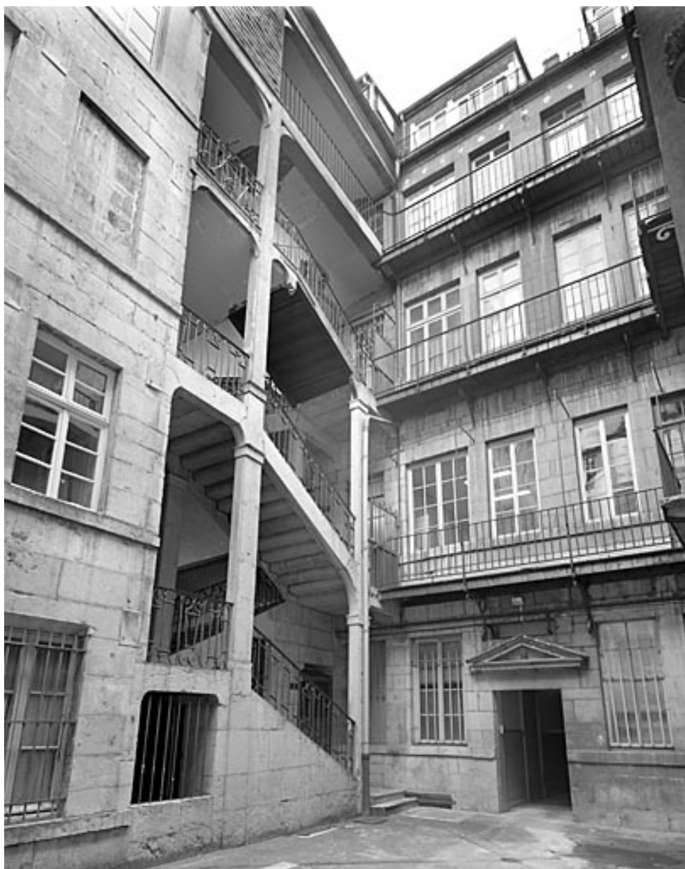
Vue d'ensemble de l'escalier à cage ouverte.
