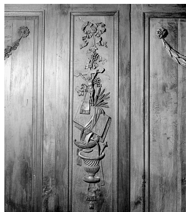
Côté sud : huitième parclose. Phot. Yves Sancey IVR43_19883900793X
