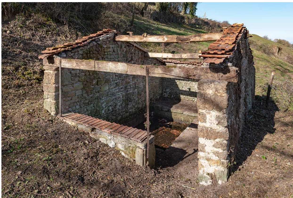
Lavoir du hameau (en cours de restauration)
