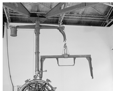
Vue latérale du support du niveau suspendu. Phot. Jérôme Mongreville IVR43_20042500023X
