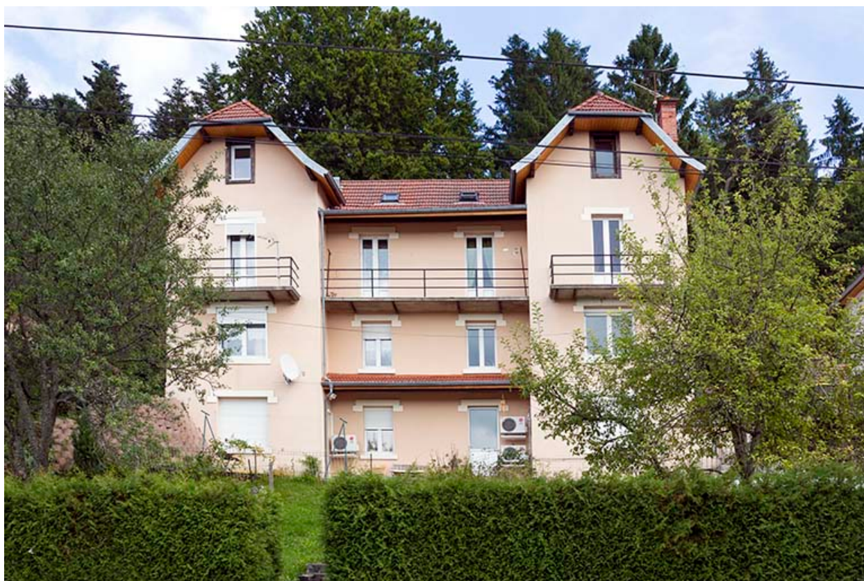
Immeuble n° 4 : façade côté vallée (ouest).
