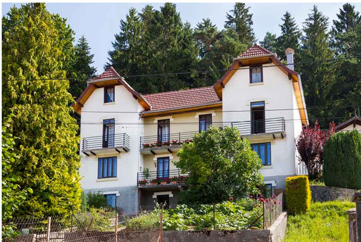
Immeuble n° 6 : façade côté vallée (ouest).
