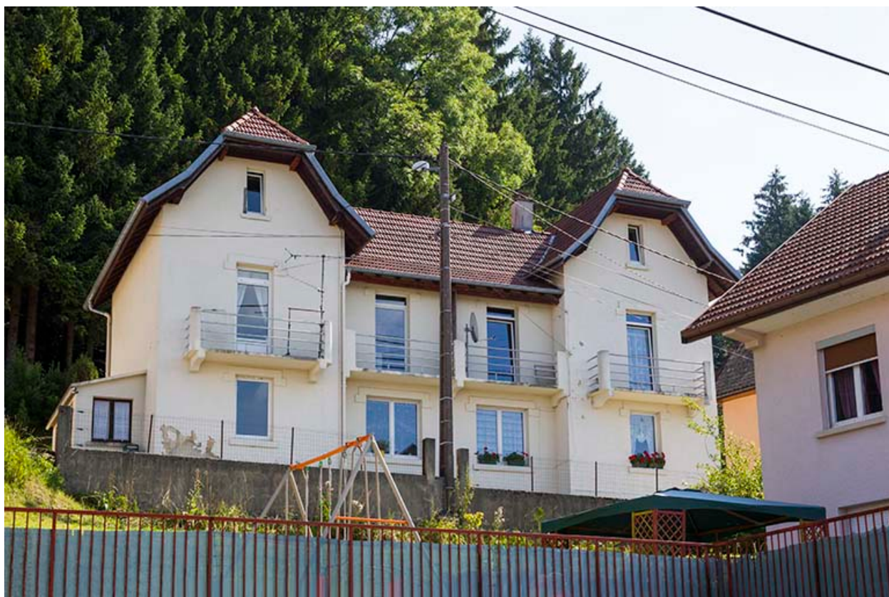
Immeuble au n° 1 : façade côté vallée (ouest).
