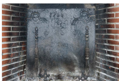
Cheminée du salon, détail de la plaque de cheminée portant la date 1738. Phot. Jérôme Mongreville IVR43_20127000493NUC4A
