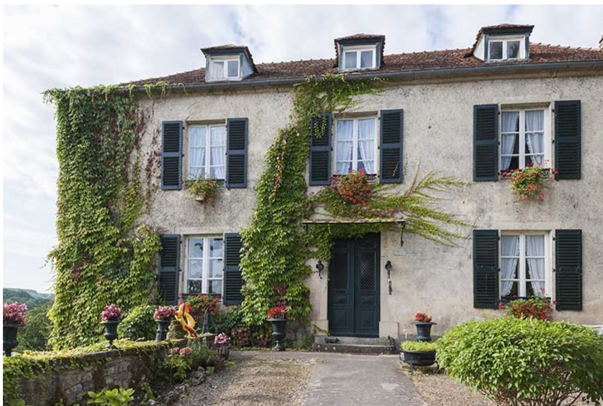
Façade antérieure sur cour.
