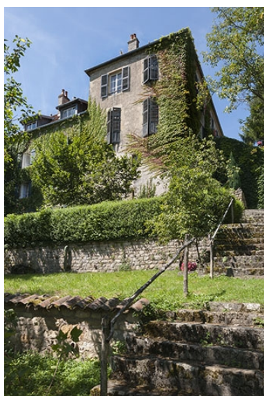
Vue générale depuis le canal du Moulin. Phot. Jérôme Mongreville IVR43_20127000494NUC4A
