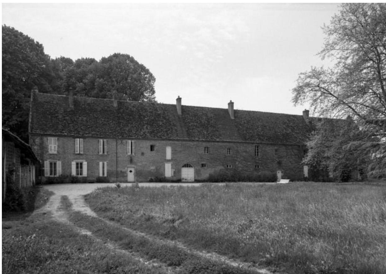
Bâtiment de l'ancien château, élévation sur cour.
