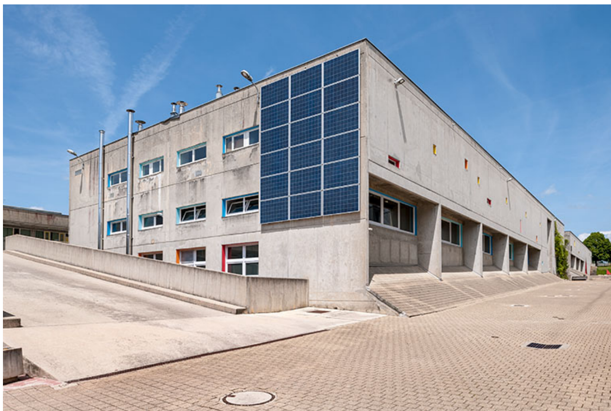
Atelier métal : pignon sud
