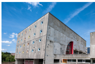
Atelier béton : façade latérale nord. Phot. Jérôme Mongreville IVR43_20143900303NUC4A
