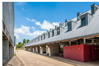
Façade sur rue intérieure du bâtiment internat - administration : toiture métallique avec chien-assis Phot. Jérôme Mongreville IVR43_20143900329NUC4A
