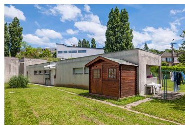
Logements : façades postérieures Phot. Jérôme Mongreville IVR43_20143900296NUC4A
