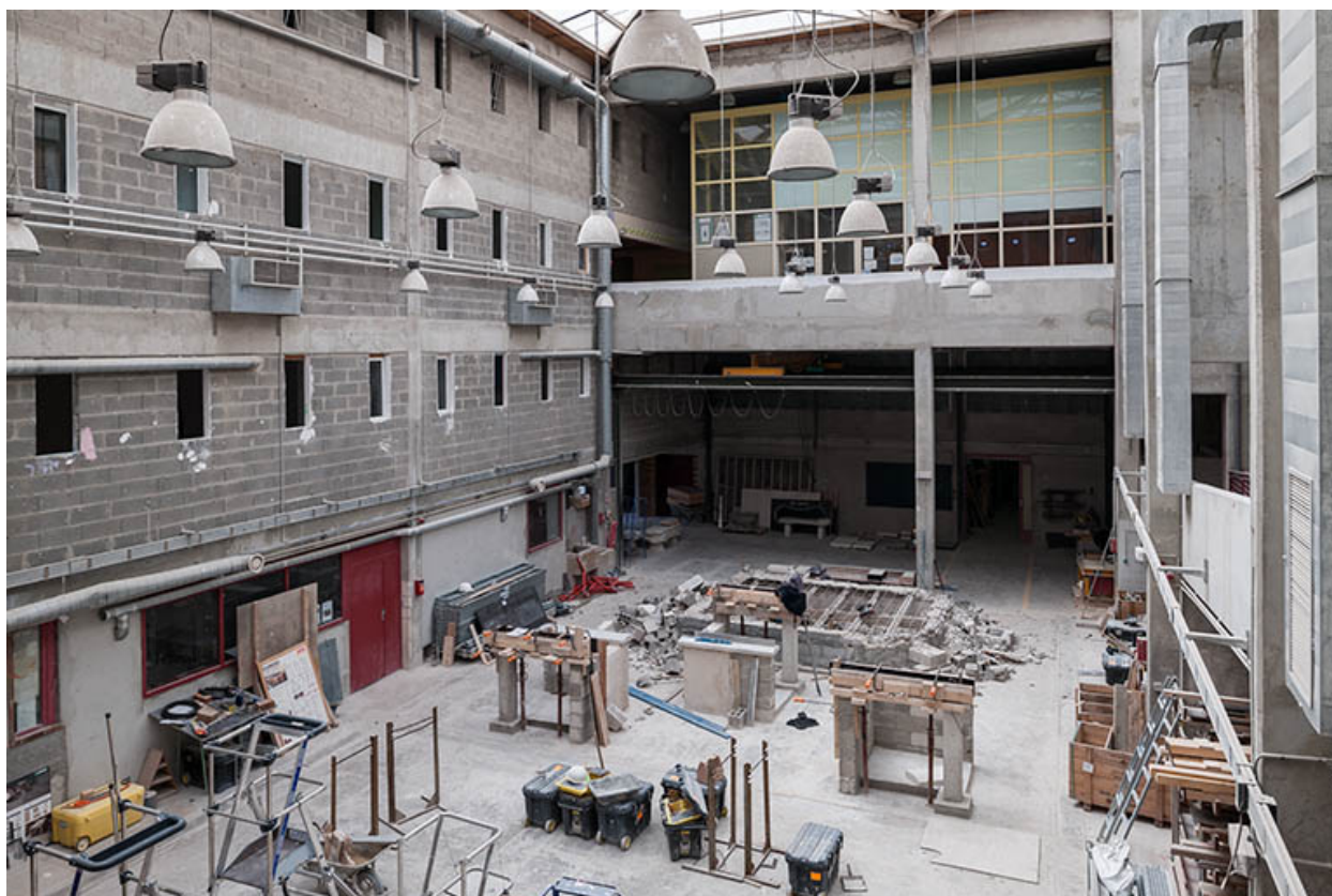
Atelier béton : intérieur, travaux pratiques.
