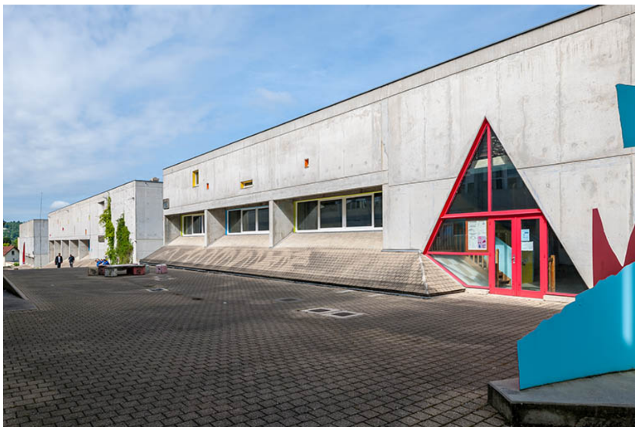
Atelier bois : façade antérieure sur rue intérieure.
