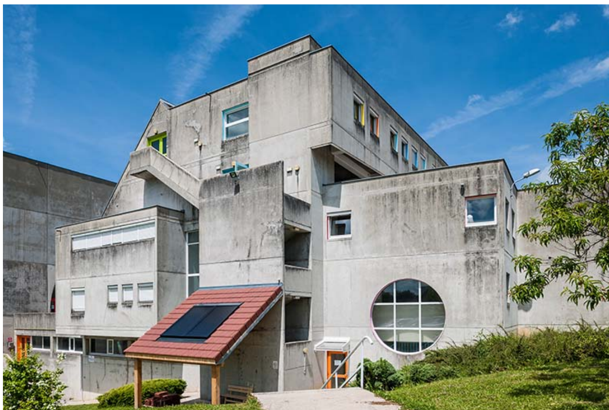
Pignon du bâtiment
