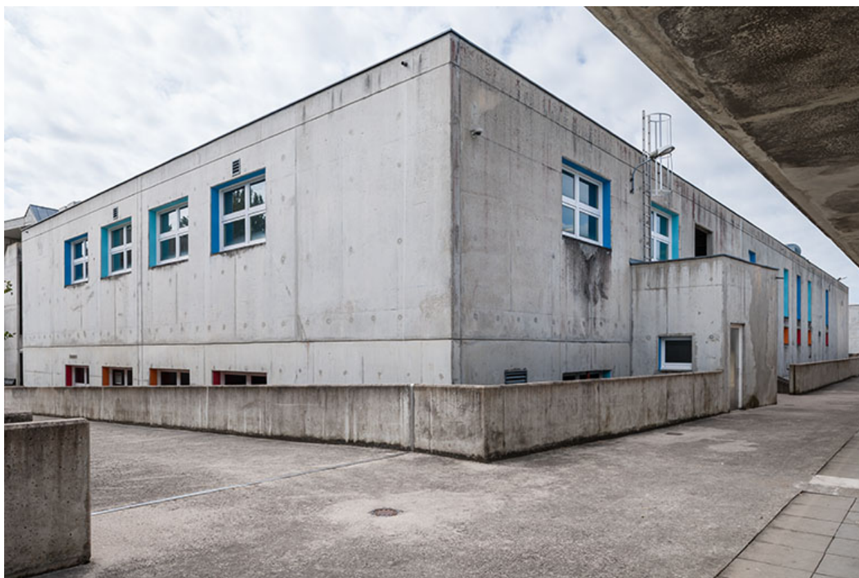
Atelier métal : façade latérale.
