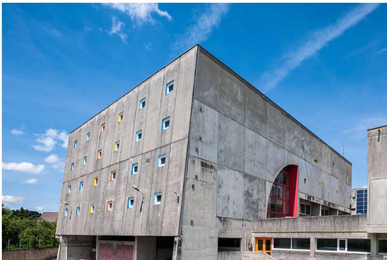
Atelier béton : façade latérale nord.
