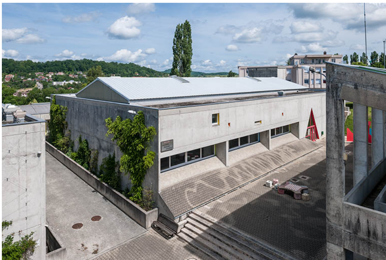
Atelier bois : vue générale
