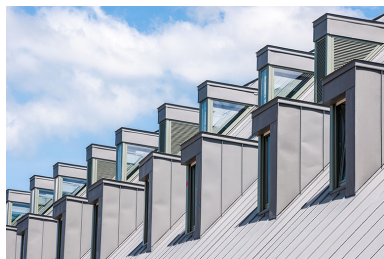
Toiture internat Phot. Jérôme Mongreville IVR43_20143900330NUC4A
