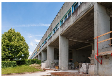
Externat : façade postérieure. Phot. Jérôme Mongreville IVR43_20143900320NUC4A
