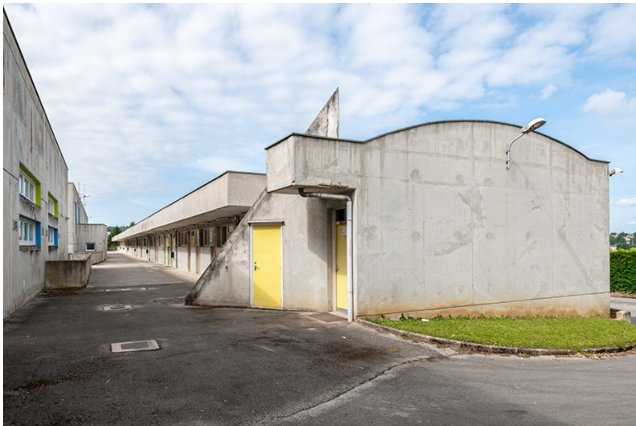
Externat : pignon nord
