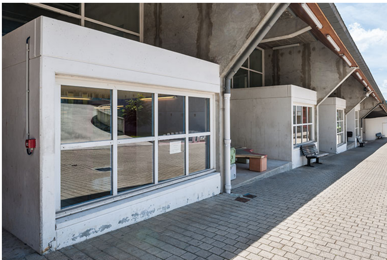
Façade en rez-de chaussée du bâtiment internat-administration
