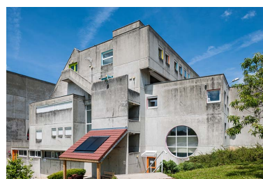
Pignon du bâtiment Phot. Jérôme Mongreville IVR43_20143900297NUC4A
