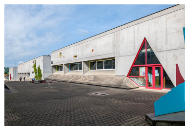
Atelier bois : façade antérieure sur rue intérieure. Phot. Jérôme Mongreville IVR43_20143900305NUC4A
