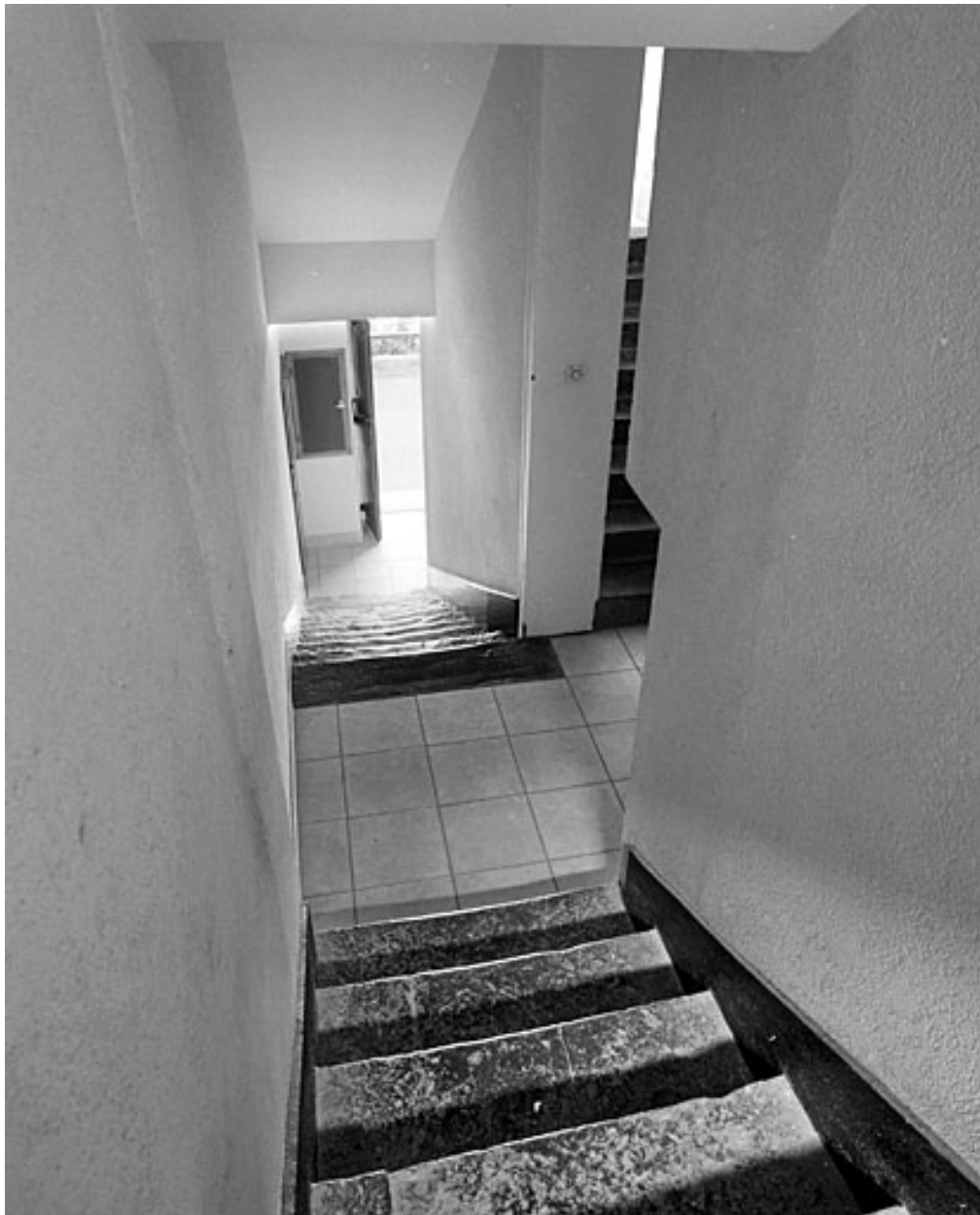
Maison au n° 32 : escalier.
