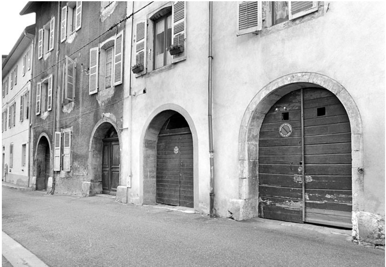
Maison au n° 30 : baies du rez-de-chaussée.
