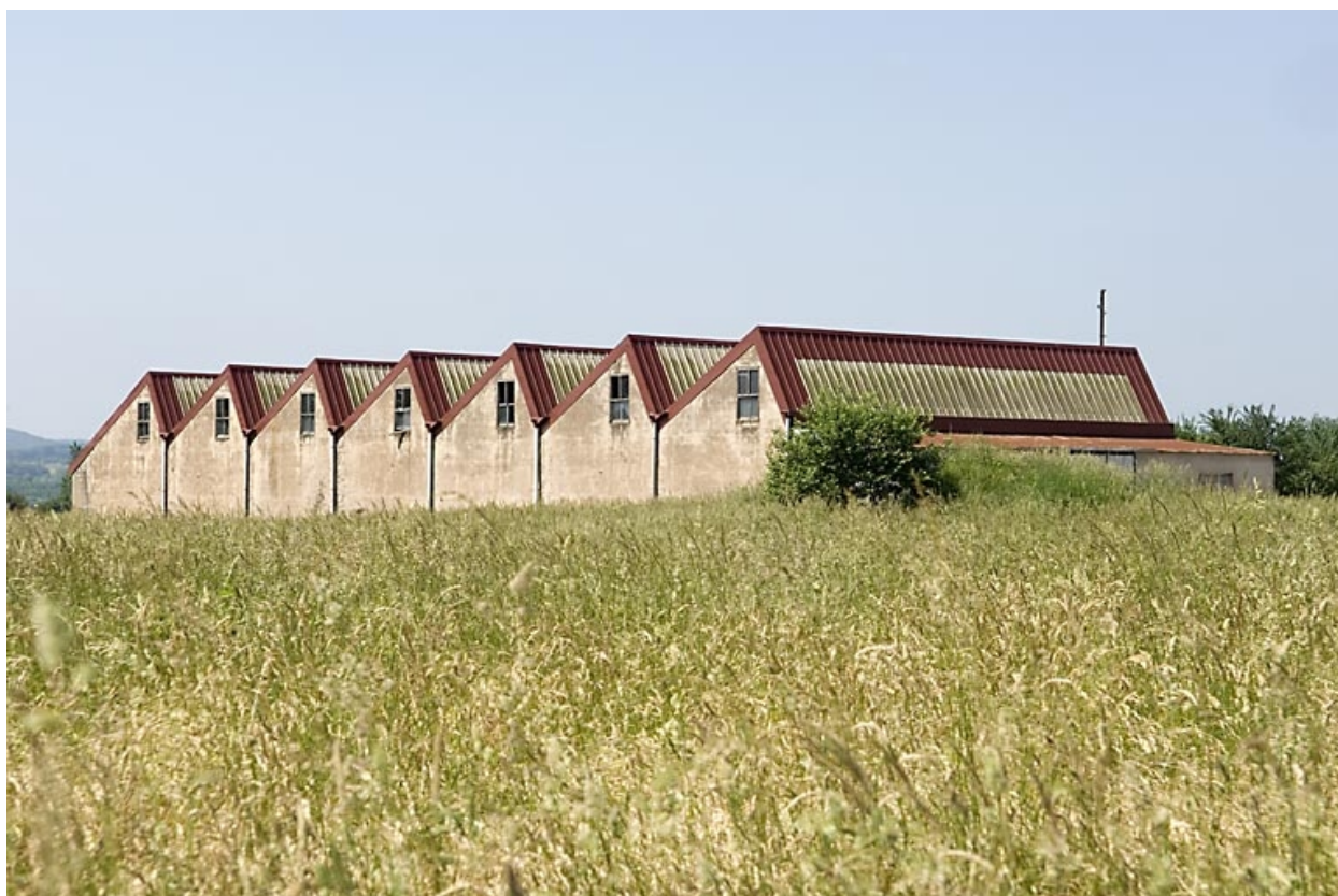
Atelier de fabrication (retorderie). Vue depuis l'est.
