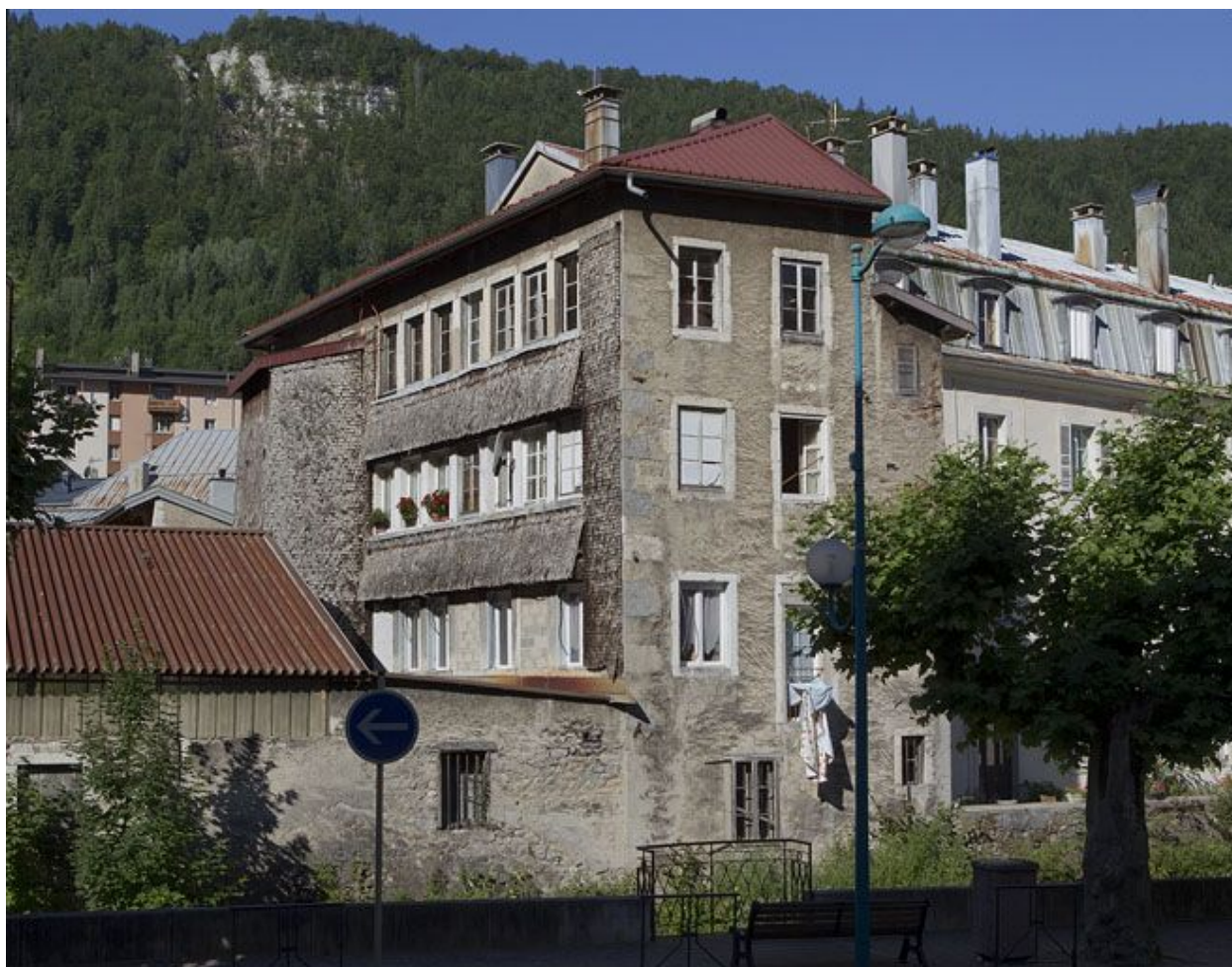
Façades postérieure et latérale droite.
