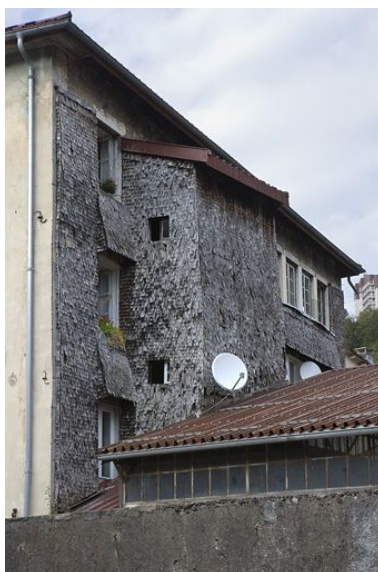
Façade latérale droite. Phot. Yves Sancey IVR43_20093900119NUC2A
