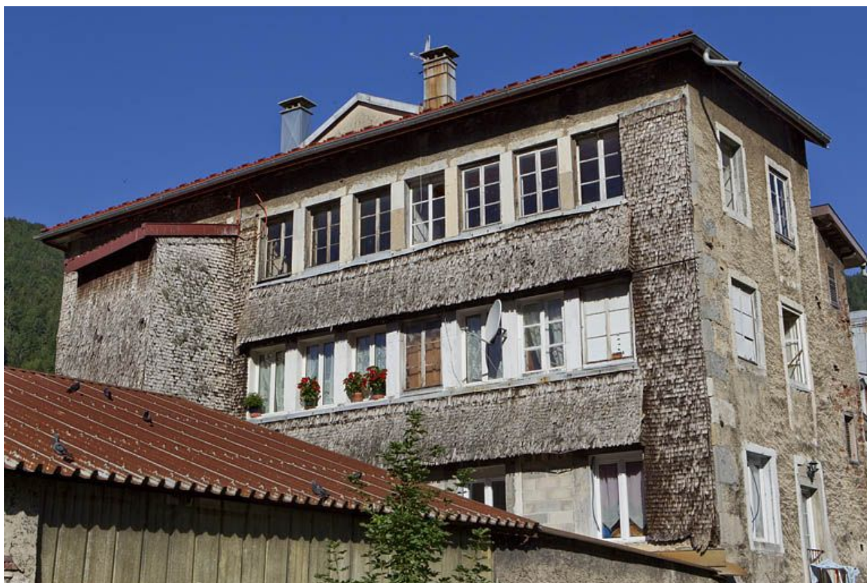
Façades postérieure et latérale droite.
