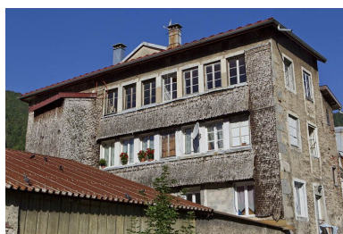
Façades postérieure et latérale droite.
