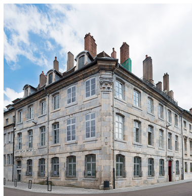
Vue d'ensemble depuis l'ouest. IVR43_20182500860NUC4A
