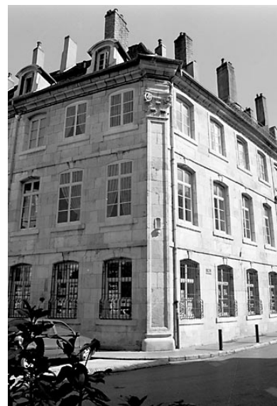
Vue d'ensemble éloignée. Phot. Yves Sancey IVR43_20012500287X
