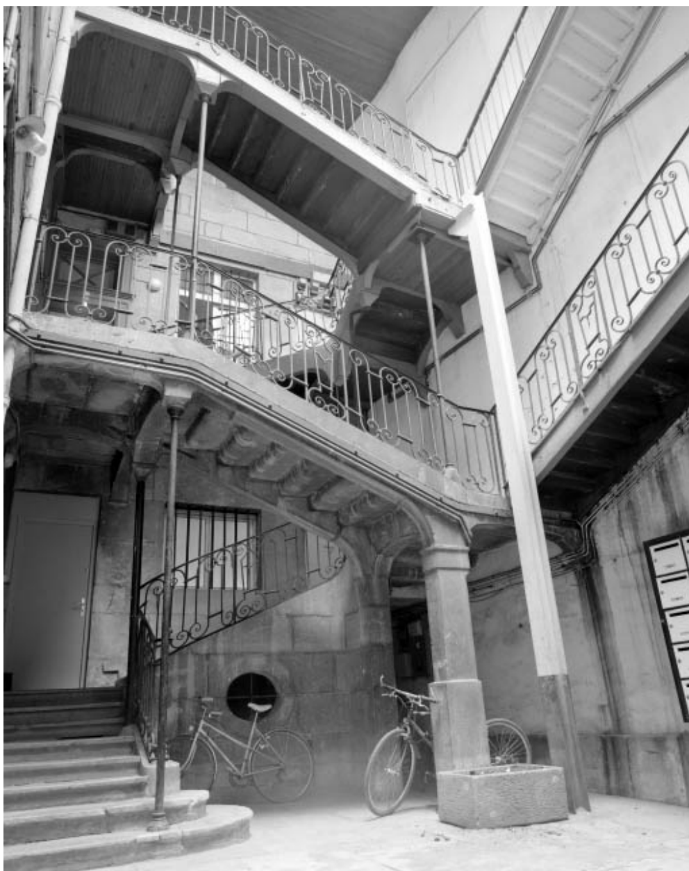
Vue d'ensemble de l'escalier à cage ouverte.
