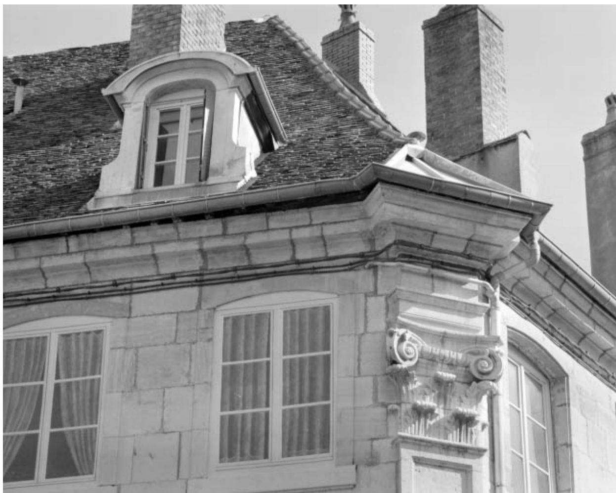
Détail du chapiteau du pilastre d'angle.
