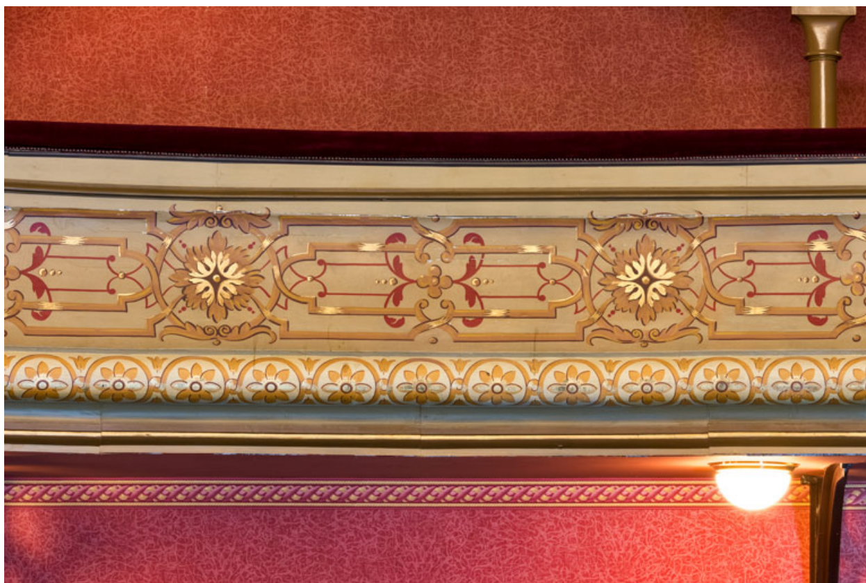
Garde-corps du 3e balcon.
