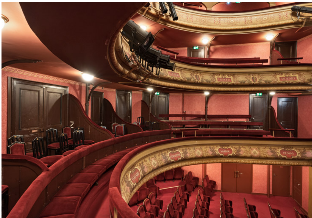
Décor des garde-corps des balcons.
