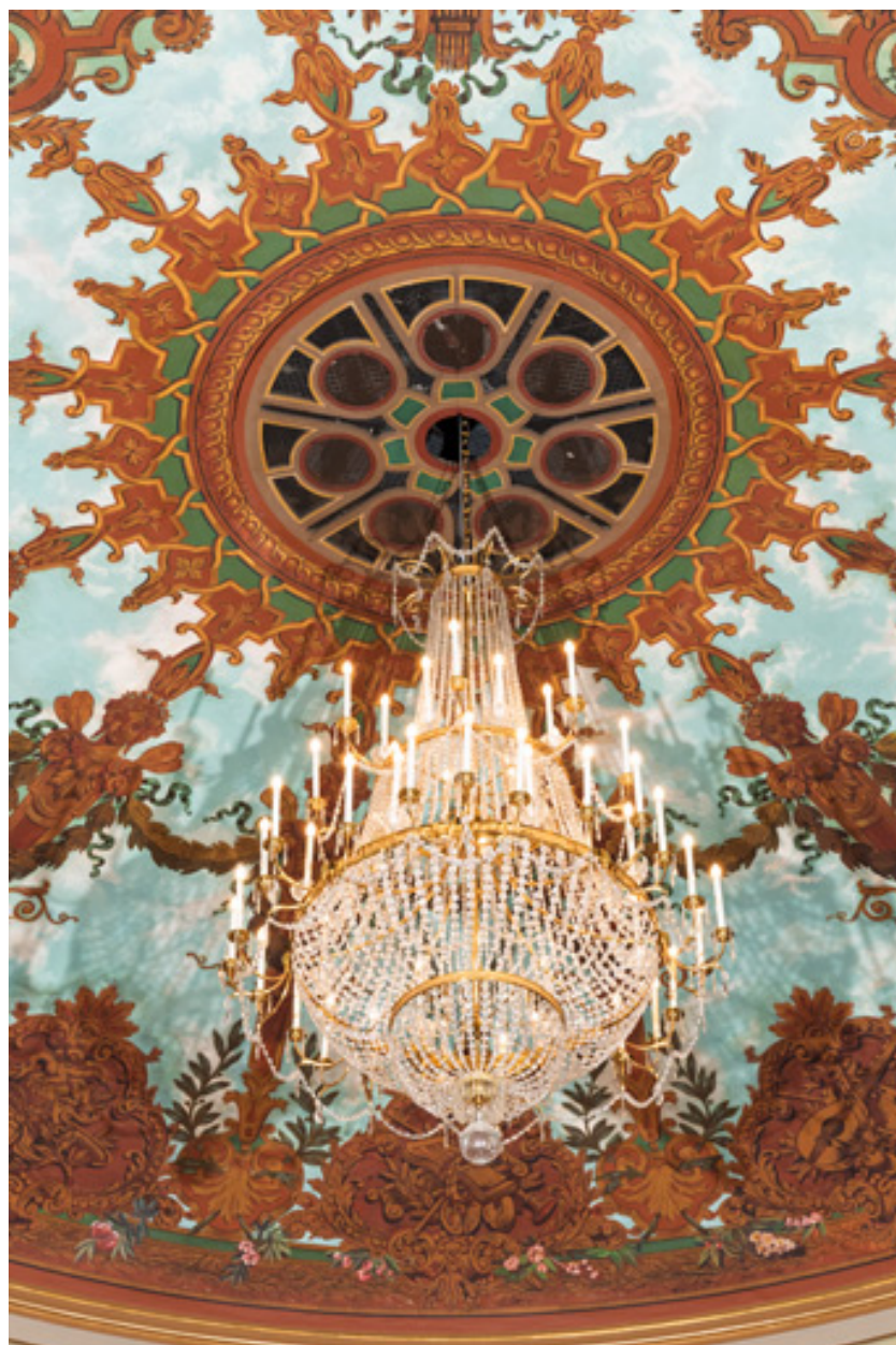
Plafond : détail de la partie centrale.
