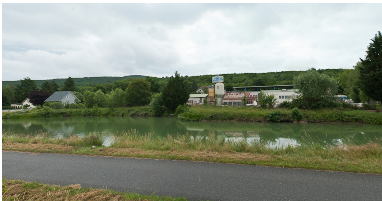
Bassin de virement de Pont-de-Pany.
