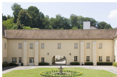
Aile ouest sur cour. Phot. Jérôme Mongreville IVR43_20097000689NUC2A
