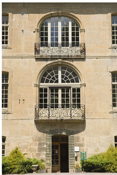
Façade sud du logis abbatial. Travée centrale. Phot. Jérôme Mongreville IVR43_20097000685NUC2A
