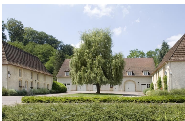
La ferme et ses dépendances. Phot. Jérôme Mongreville IVR43_20097000695NUC2A
