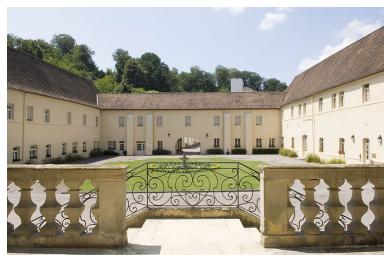
Bâtiments sur cour. Phot. Jérôme Mongreville IVR43_20097000687NUC2A
