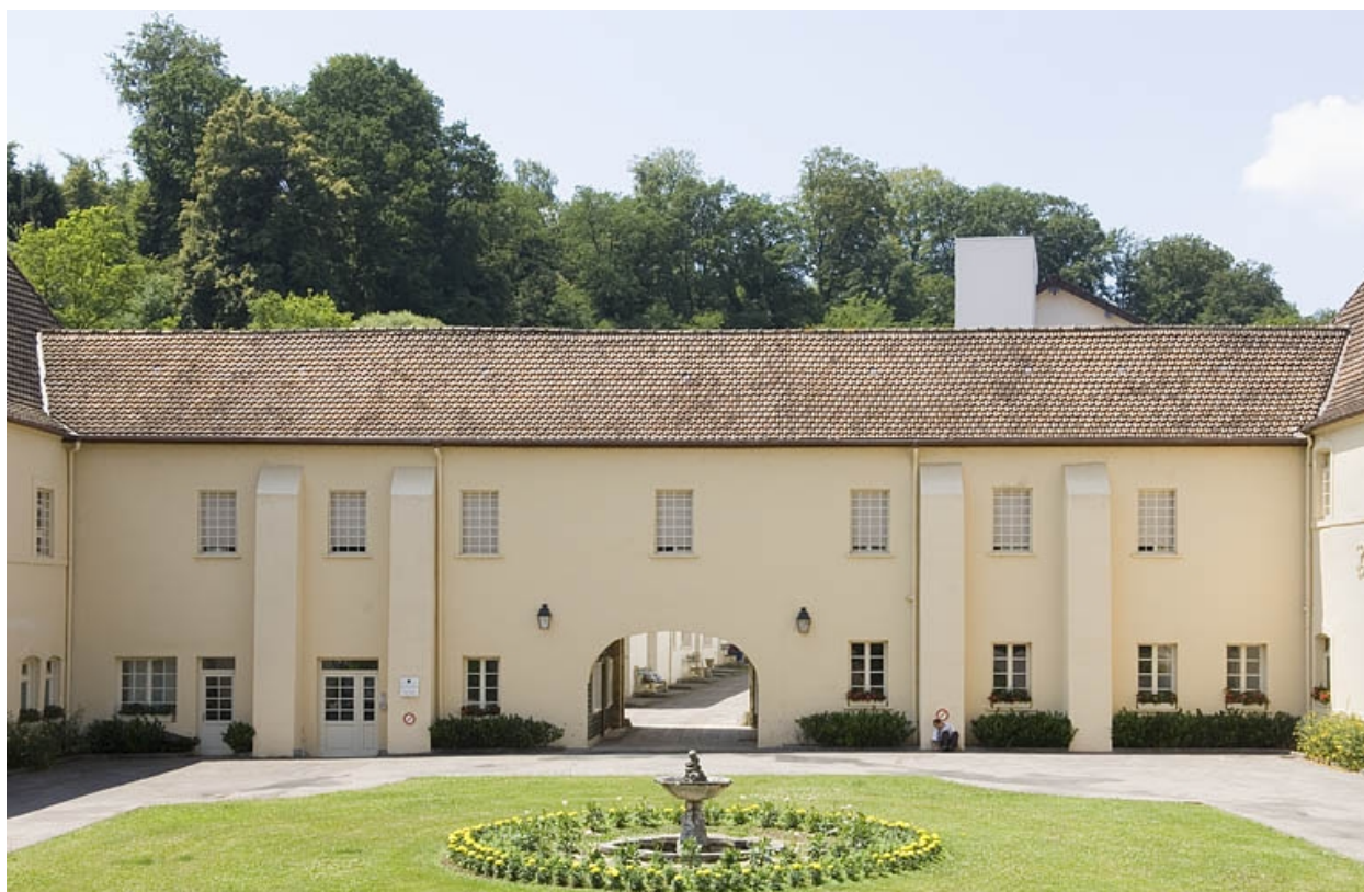
Aile ouest sur cour.
