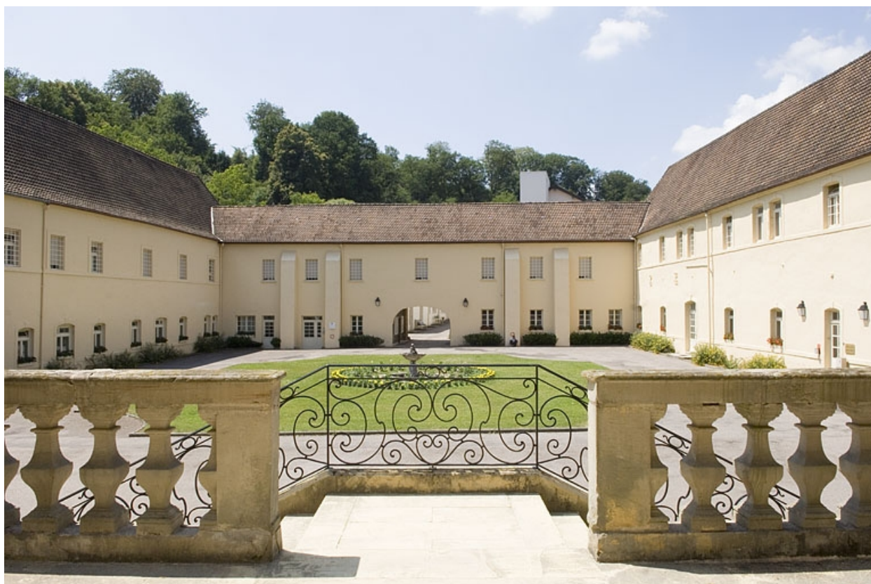
Bâtiments sur cour.
