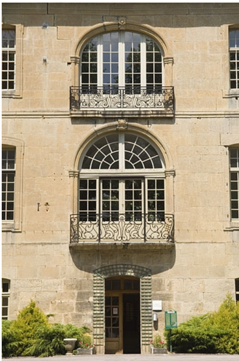
Façade sud du logis abbatial. Travée centrale.
