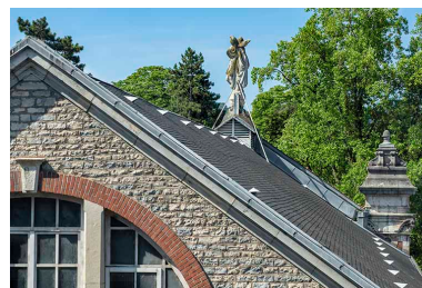
Toiture, vue depuis le nord. Phot. Jérôme Mongreville IVR43_20232500418NUC4A
