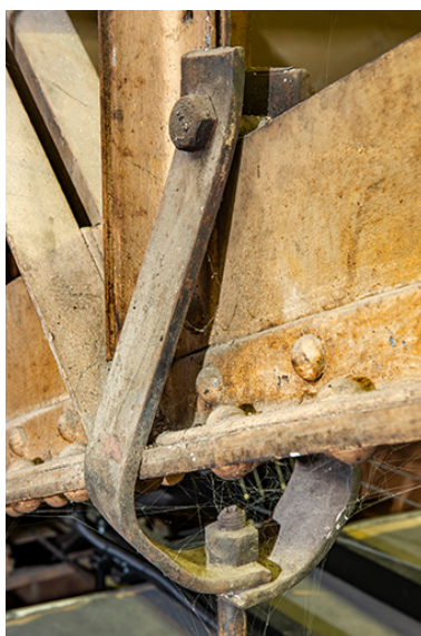
Charpente métallique au- dessus des gradins, étrier de fixation des passerelles. Phot. Jérôme Mongreville IVR43_20232500324NUC4A
