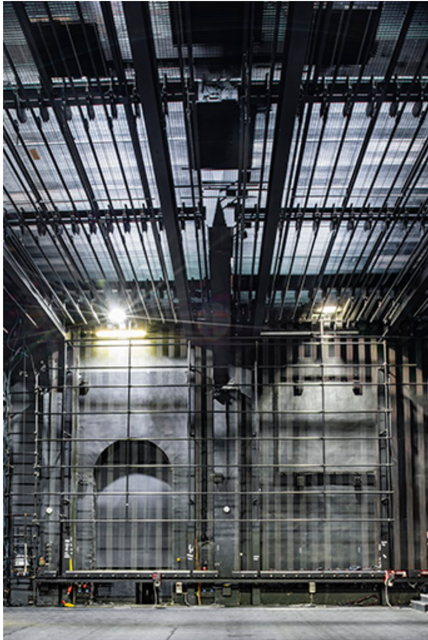
Salle, mur latéral nord-ouest, vue de face.
