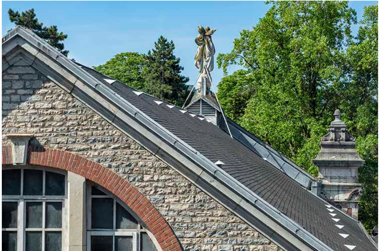
Toiture, vue depuis le nord.
