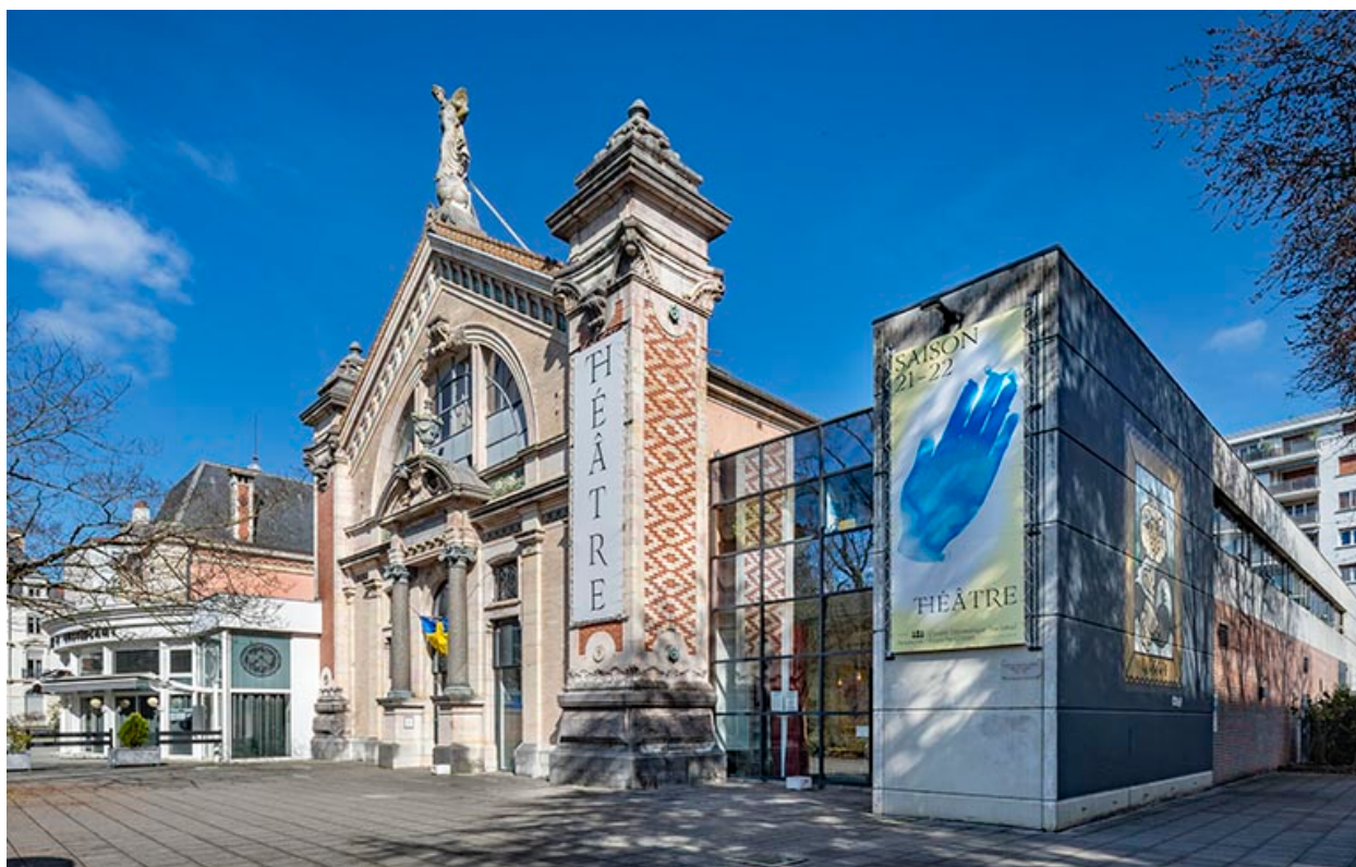
Vue d'ensemble, avec l'extension à droite.
