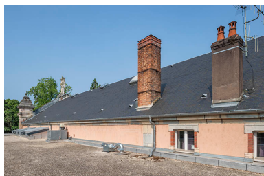
Toiture, vue depuis l'est. Phot. Jérôme Mongreville IVR43_20232500438NUC4A
