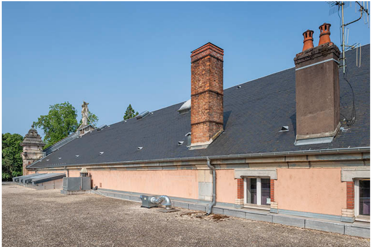
Toiture, vue depuis l'est.
