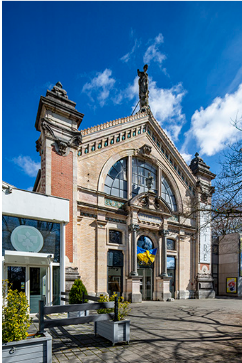
Façade principale, vue de trois quarts.
