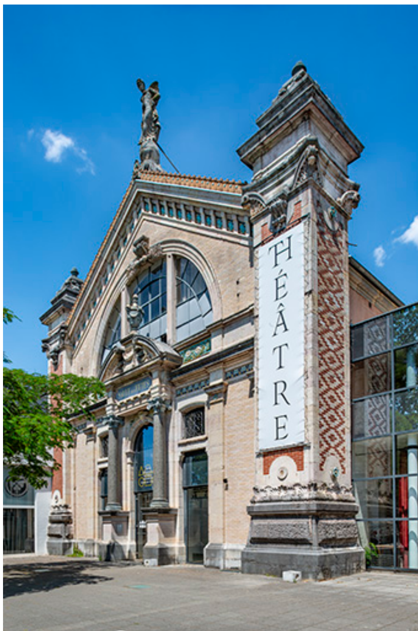
Façade principale, vue de trois quarts.
