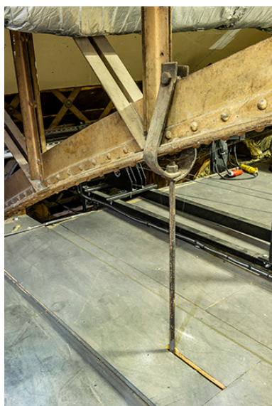
Charpente métallique au- dessus des gradins, étrier de fixation des passerelles. Phot. Jérôme Mongreville IVR43_20232500325NUC4A
