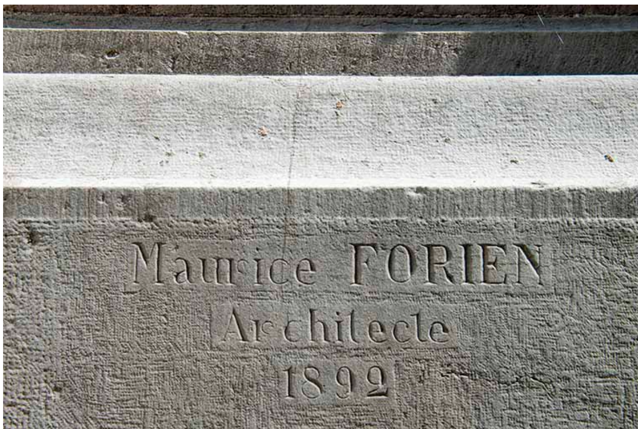
Façade principale, signature : "Maurice FORIEN architecte 1892".
