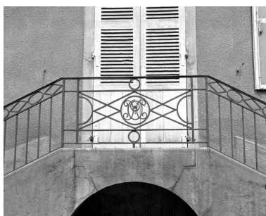
Façade antérieure du logis : détail du perron. Phot. Yves Sancey IVR43_19843900373X
