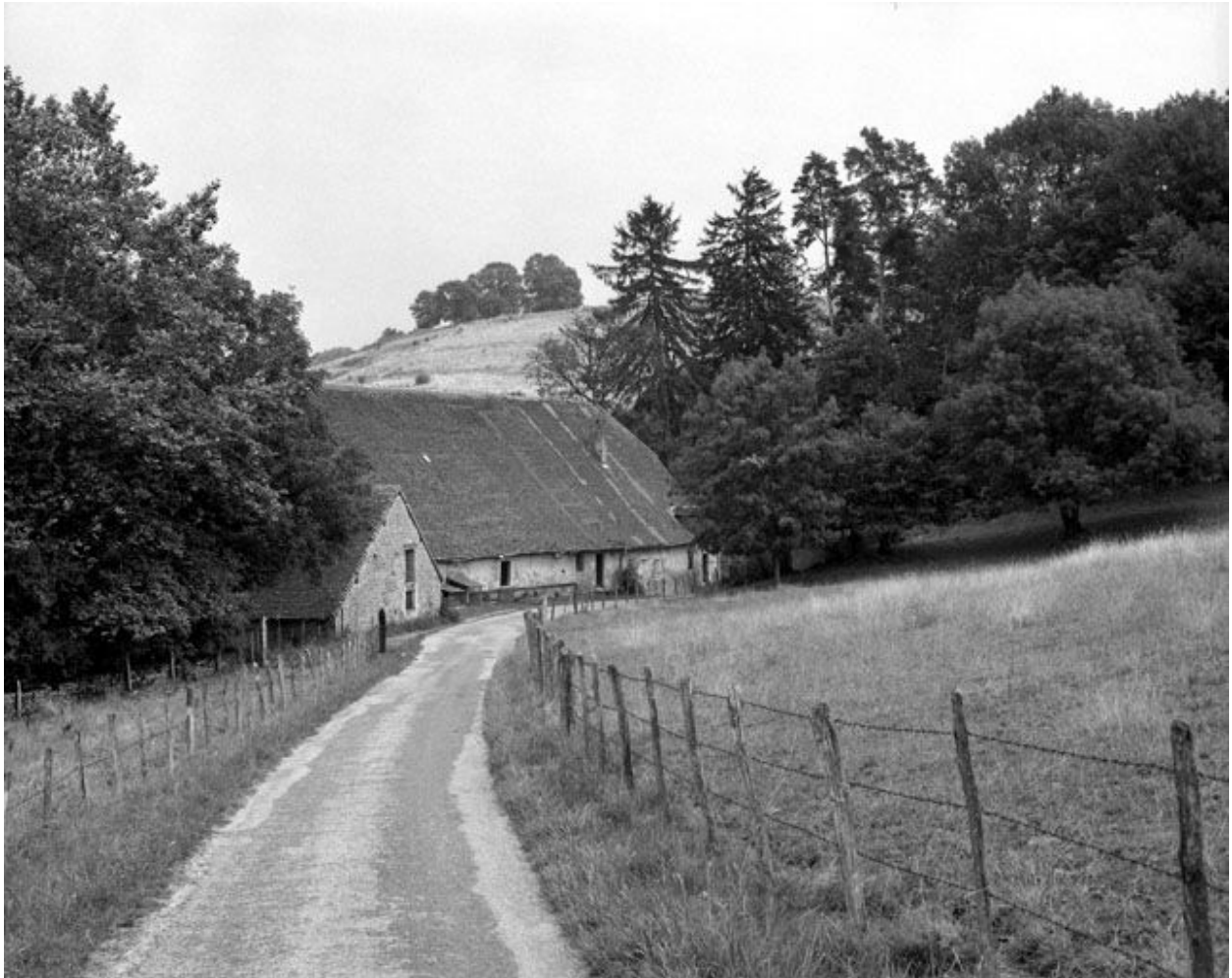
Les parties agricoles vues depuis l'ouest.
