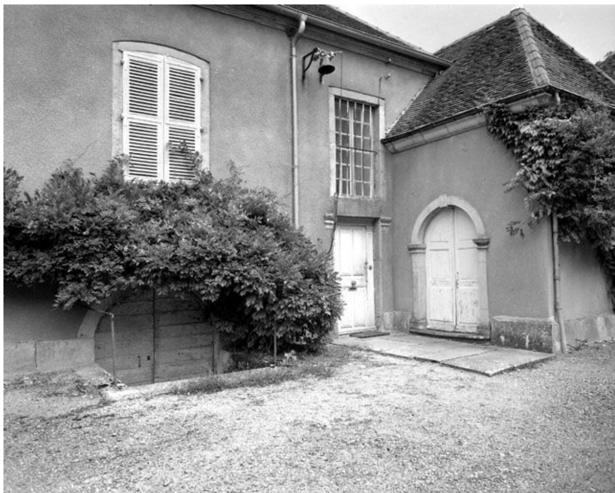
Façade antérieure du logis : partie droite.
