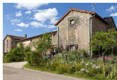
Fermes mitoyennes avec corps de logis symétriques. Phot. Sonia Dourlot IVR43_20157001083NUC2A
