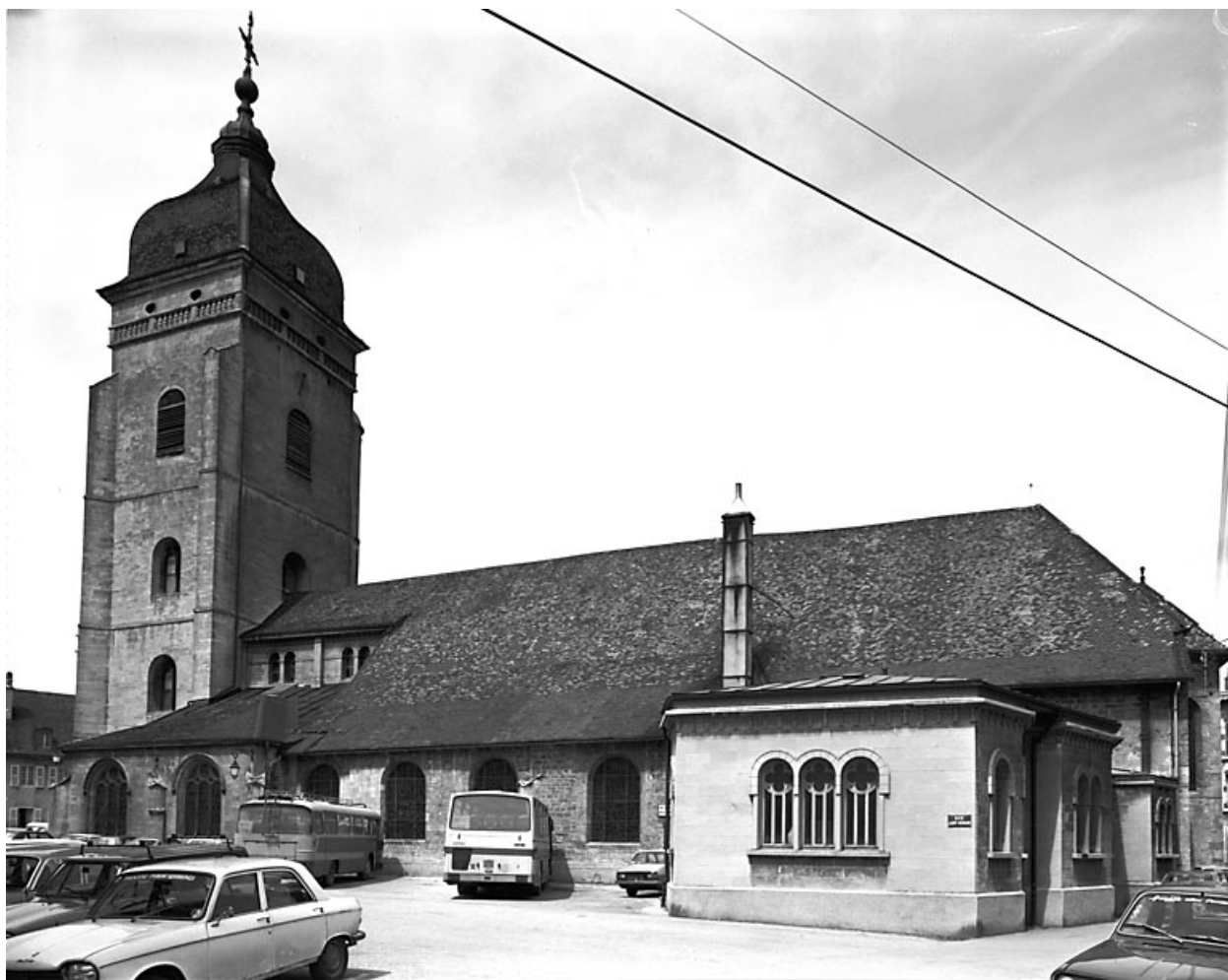
Façade latérale droite.
