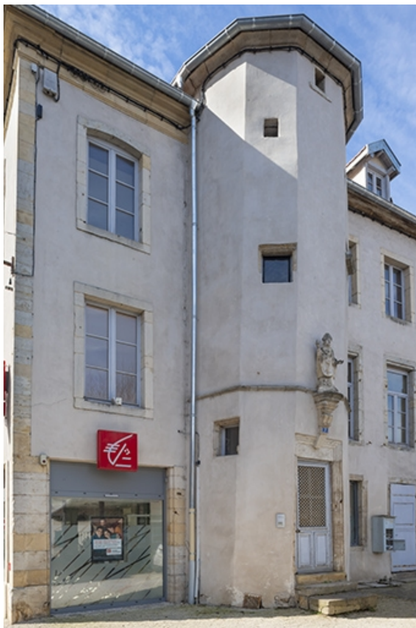
Trois quarts gauche de la tour d'escalier.
