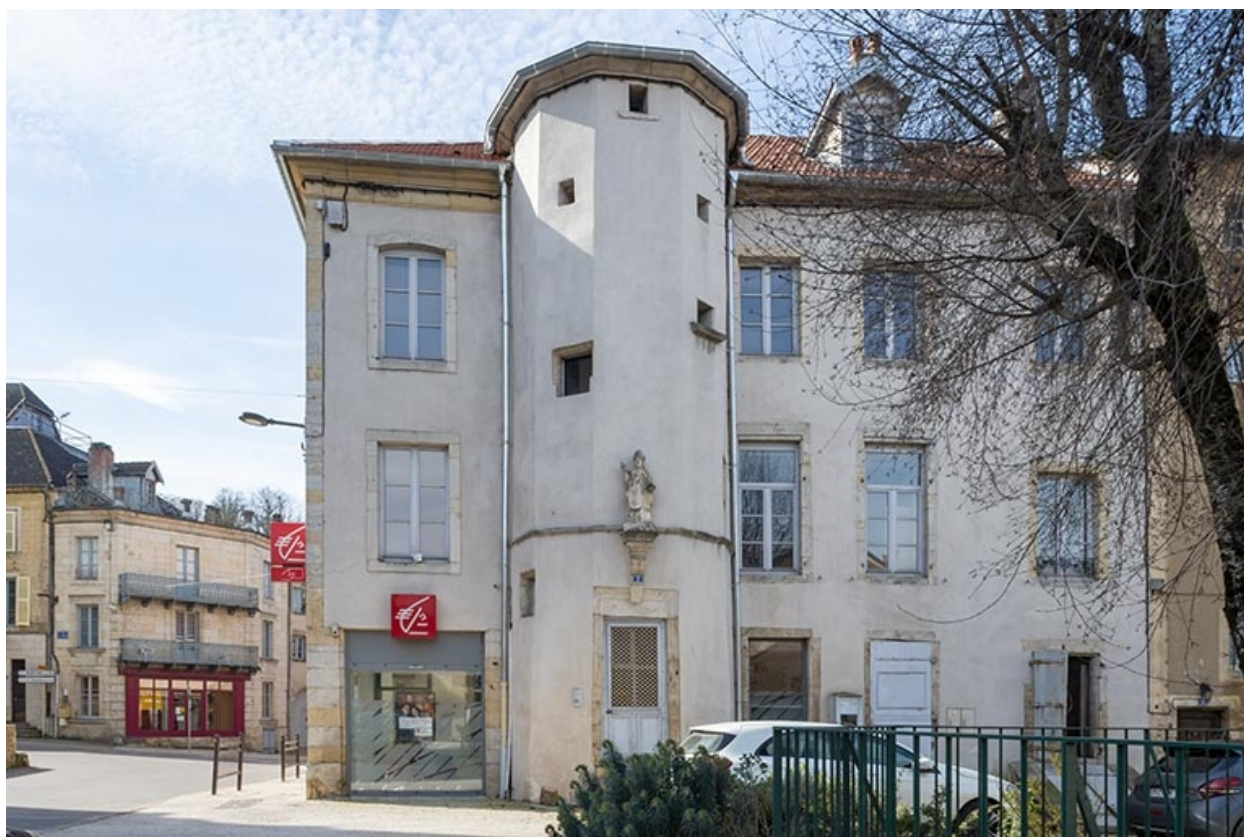
Façade orientale de la maison.
