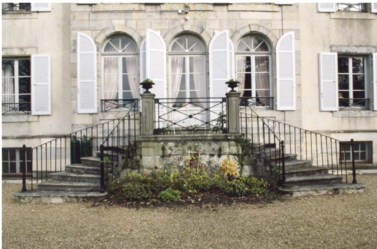
Détail de la façade ouest.
