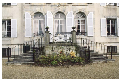
Détail de la façade ouest. Phot. Yves Sancey IVR43_20009000867ZA
