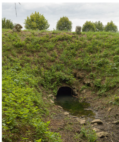
Vue de l'aqueduc.
