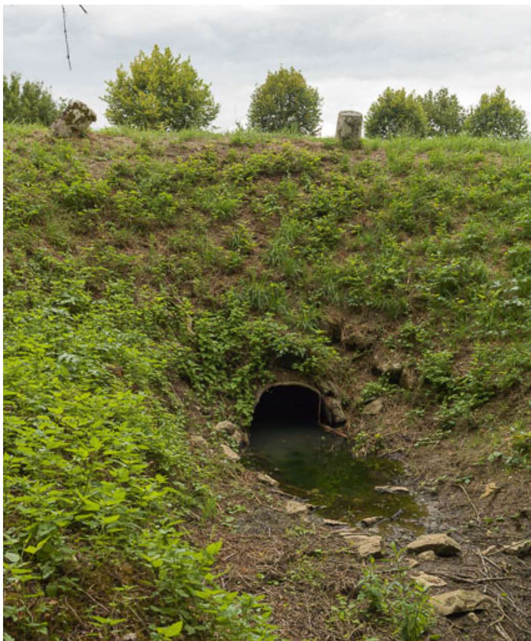
Vue de l'aqueduc.
