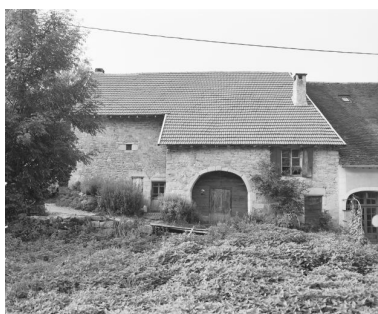
Ferme située rue du Tonkin. Phot. Yves Sancey IVR43_19793900130X
