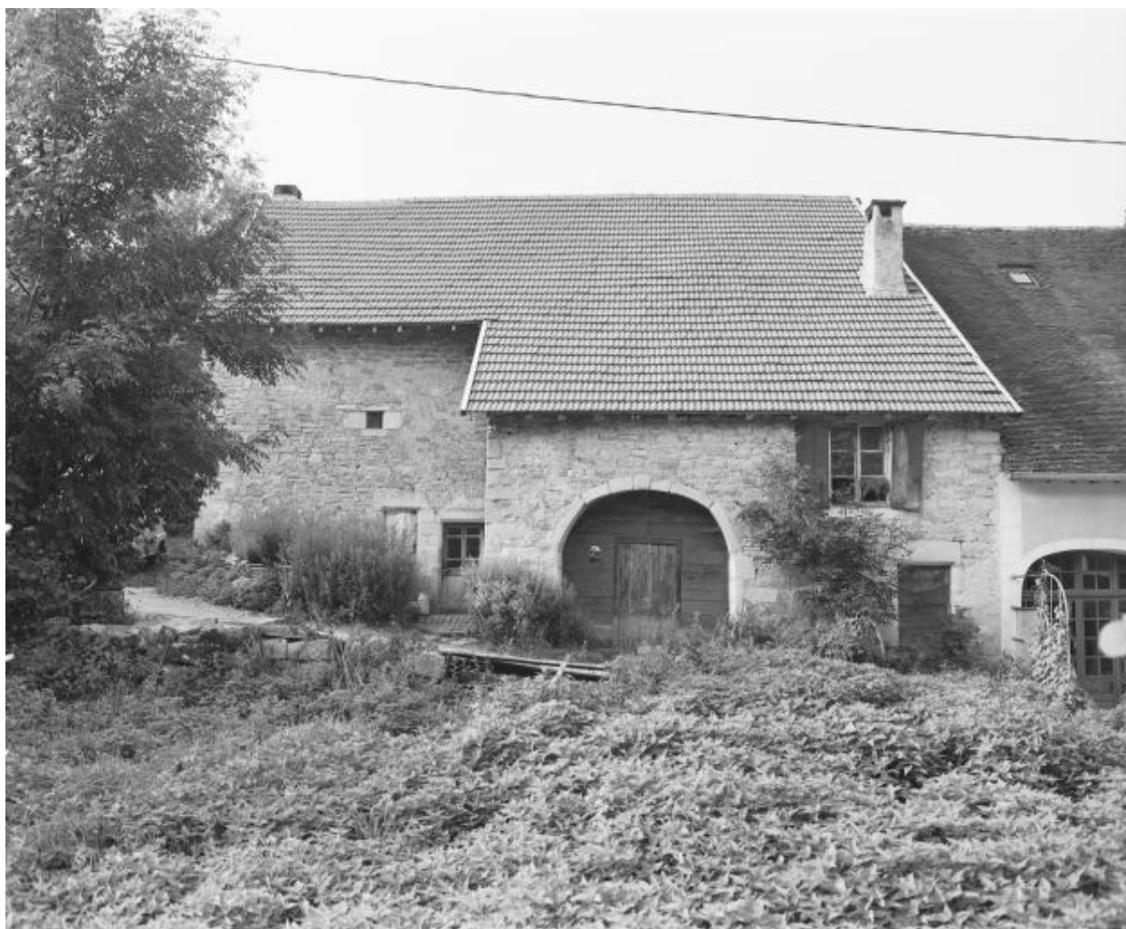
Ferme située rue du Tonkin.
