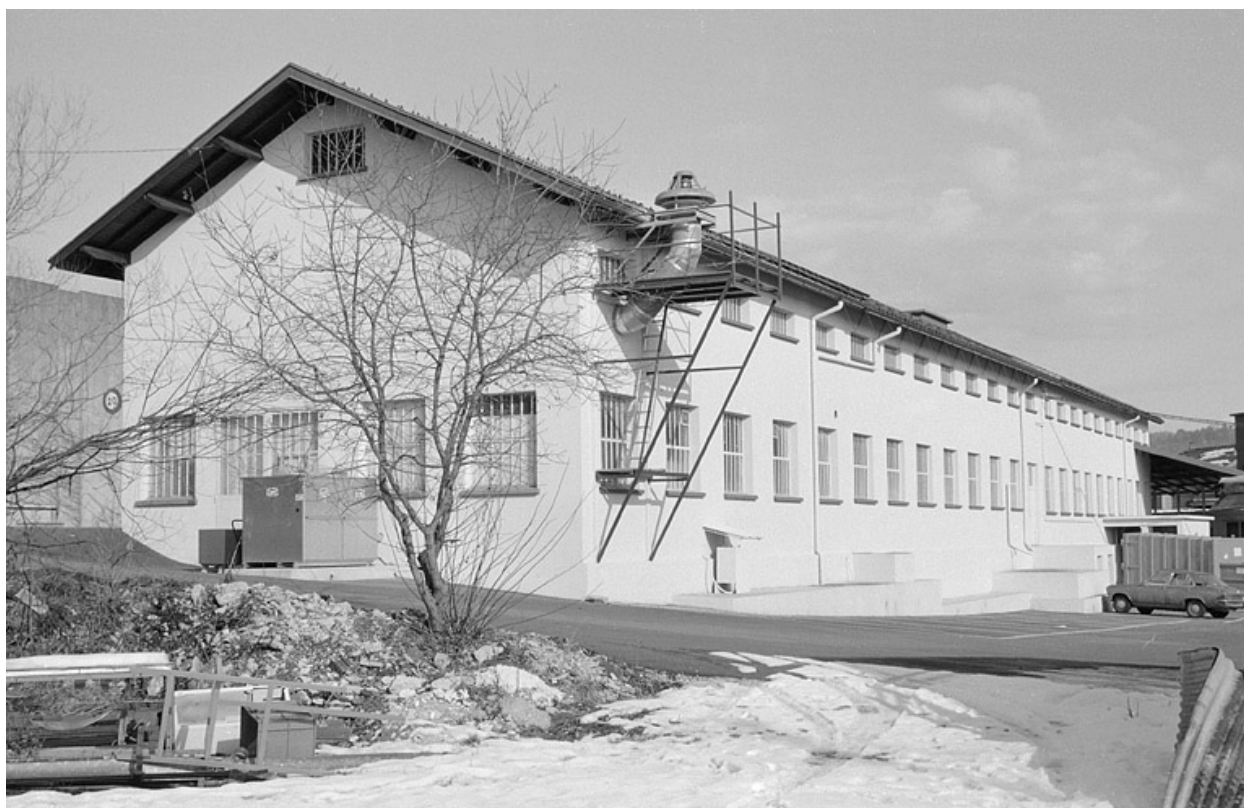
Atelier de fabrication (P).
