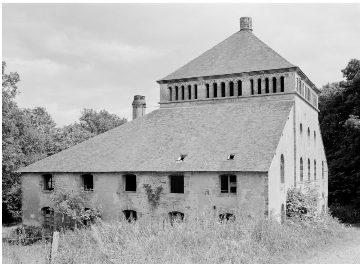
Vue depuis le nord-ouest, état en 1977.
