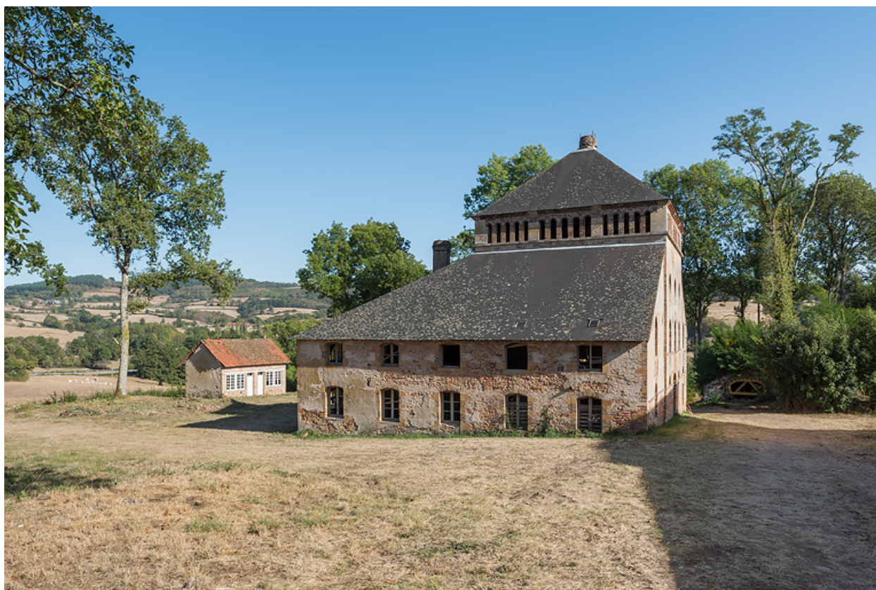
Vue depuis le nord-ouest, état actuel.
