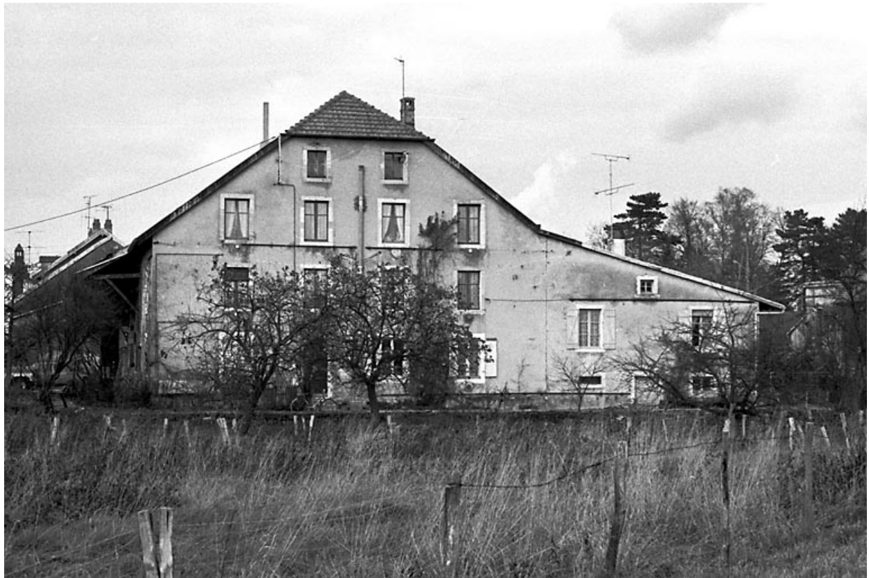
Vue du pignon droit de l'habitation.
