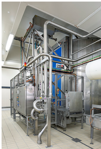
Tour de pressage : vue arrière. Phot. Sonia Dourlot IVR43_20192500921NUC4A
