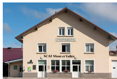
Bâtiment de 1820 : façade antérieure. Phot. Sonia Dourlot IVR43_20192500913NUC4A
