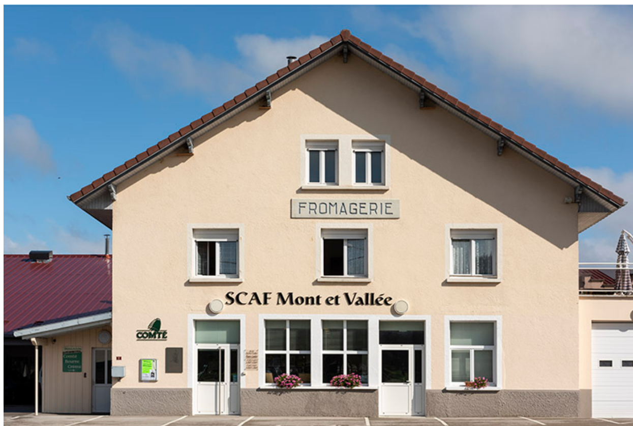
Bâtiment de 1820 : façade antérieure.
