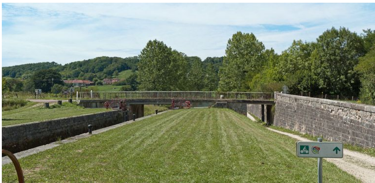
Vue du pont routier depuis l'amont.
