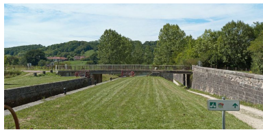
Vue du pont routier depuis l'amont. Phot. Pierre-Marie Barbe-Richaud IVR26_20112103851NUC4AQ
