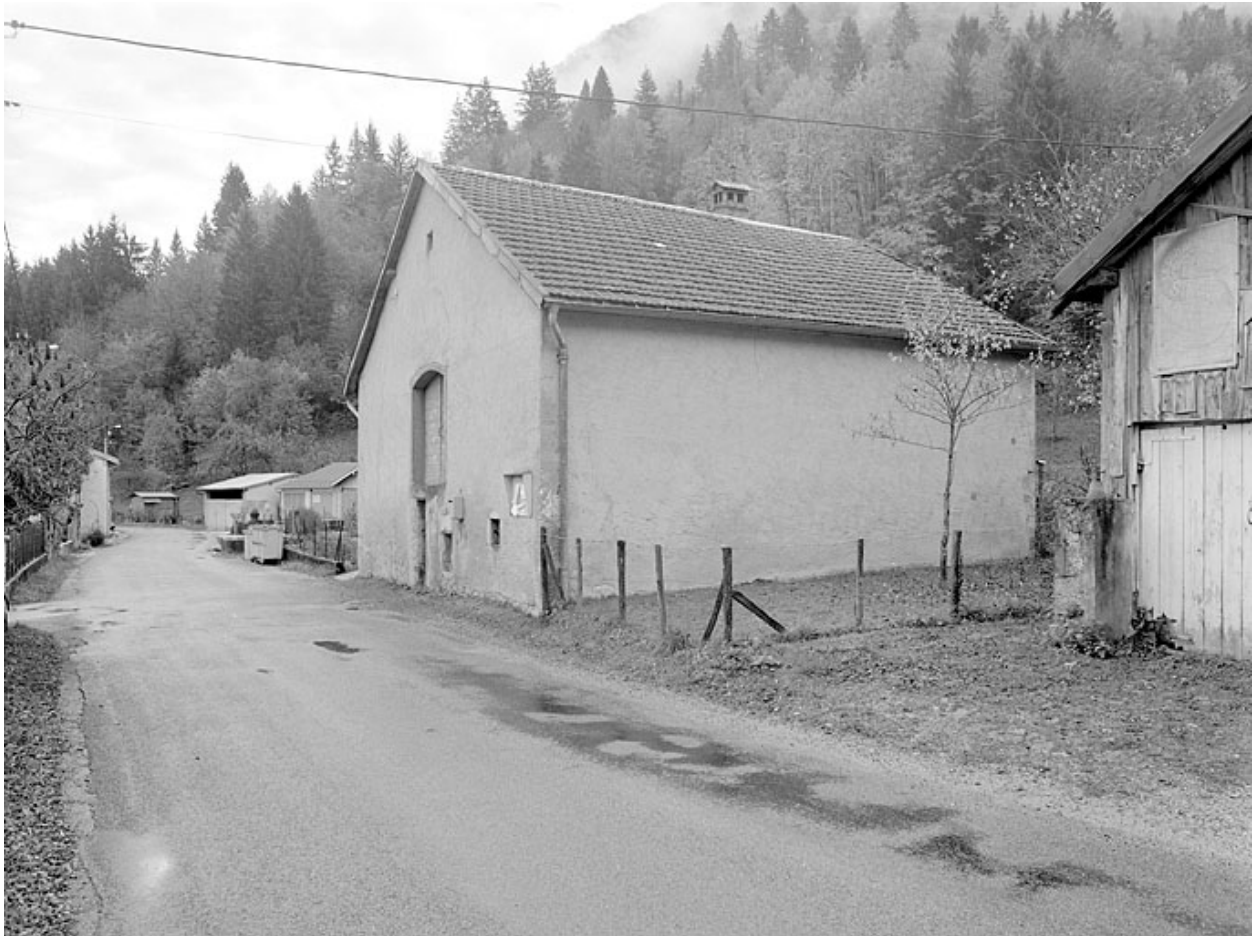
Face nord et façade postérieure.
