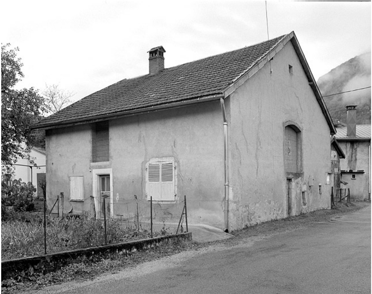
Façade antérieure et face droite.
