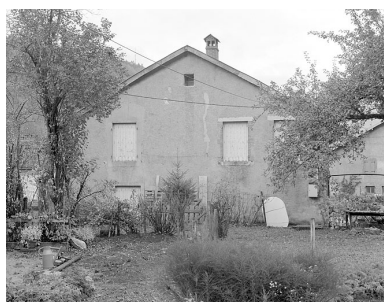
Face sud. Phot. Jérôme Mongreville IVR43_19963901638X
