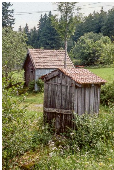
Resserre appelée "grenier fort", vue éloignée.
