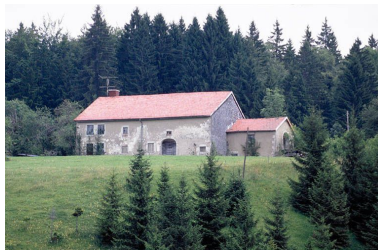
Vue éloignée de la façade postérieure.
