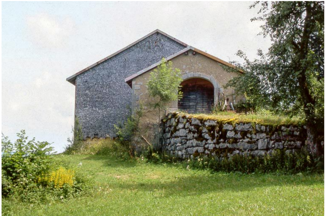
Face gauche et levée de grange.
