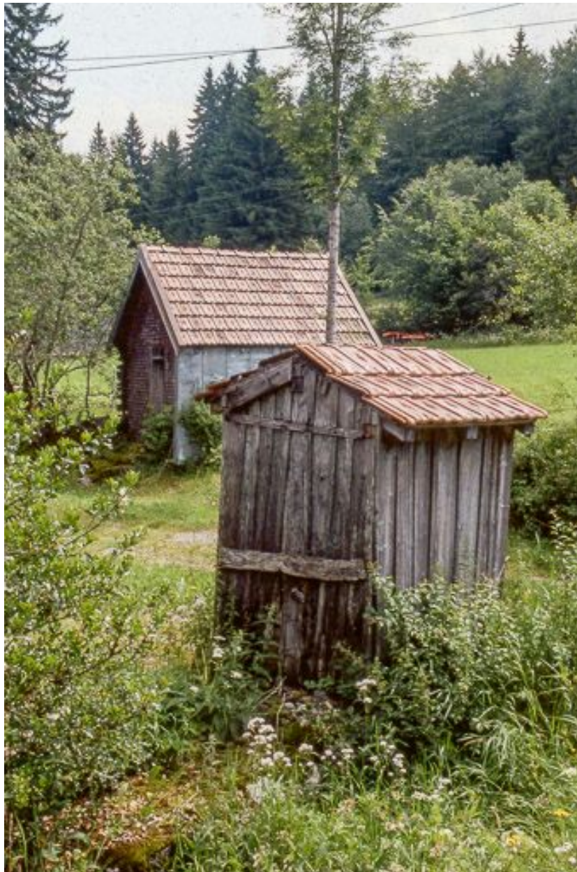
Resserre appelée "grenier fort", vue éloignée.
