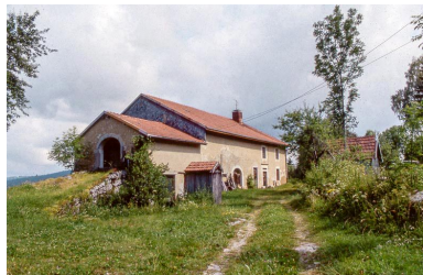
Vue éloignée de la façade antérieure.
