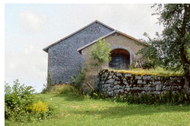
Face gauche et levée de grange.
