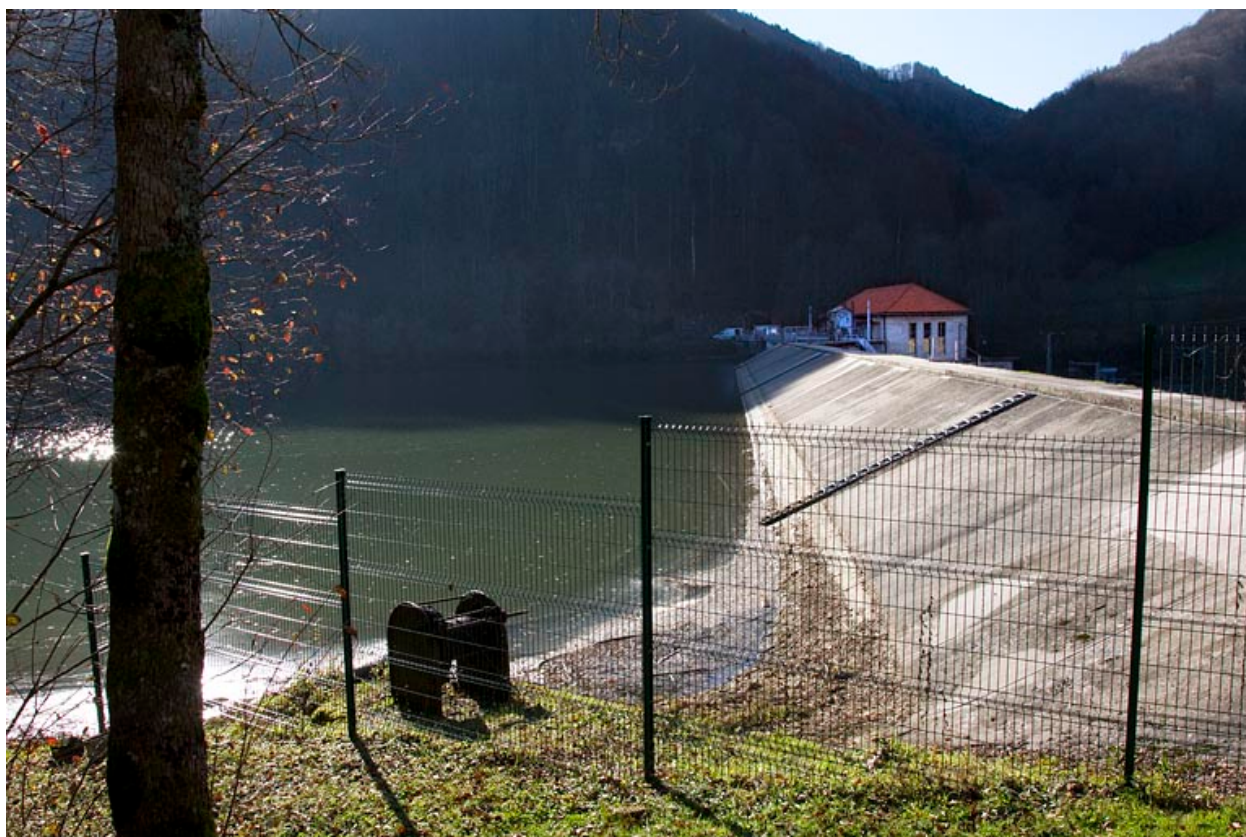
La digue depuis la rive droite.
