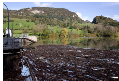
Barrage : amoncellement de branches et débris en amont. Phot. Yves Sancey IVR43_20122502194NUC2A
