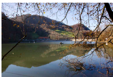
Digue et retenue, depuis l'amont. Phot. Yves Sancey IVR43_20122502202NUC2A
