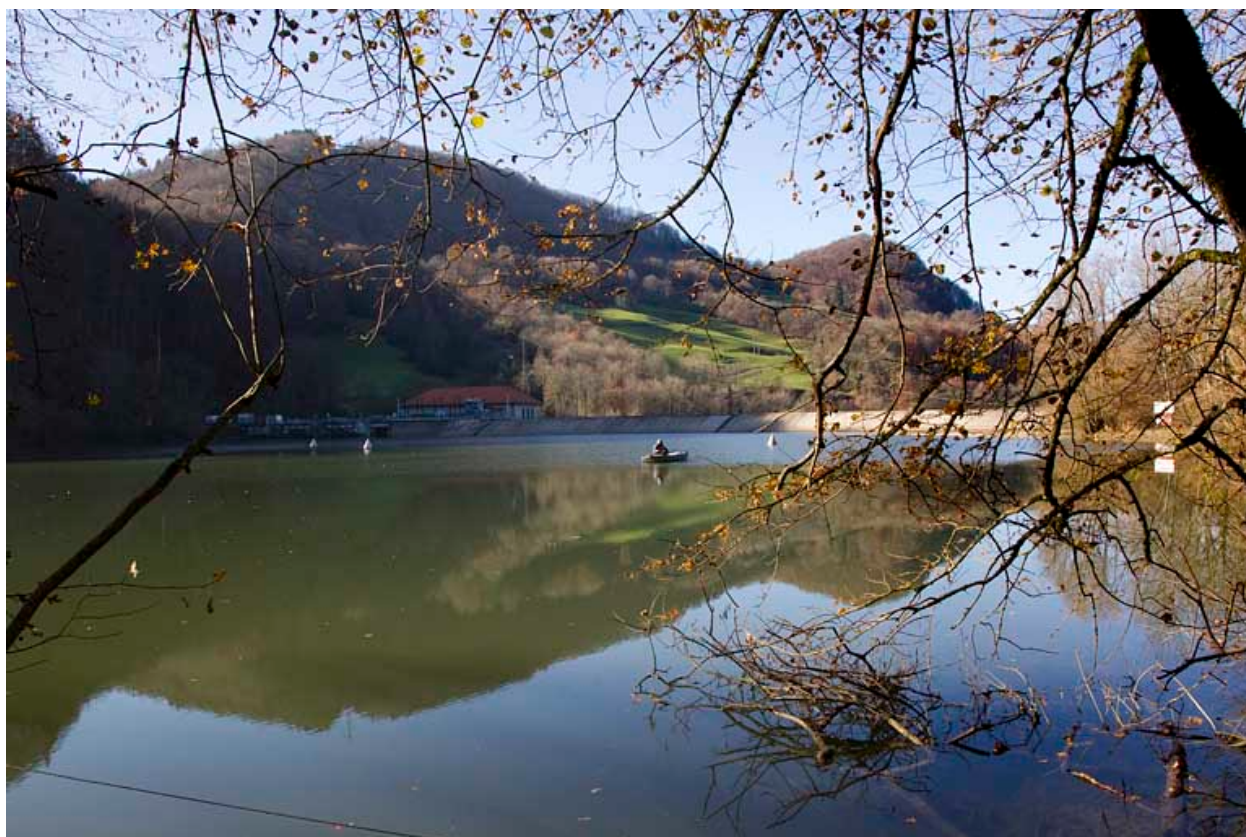
Digue et retenue, depuis l'amont.
