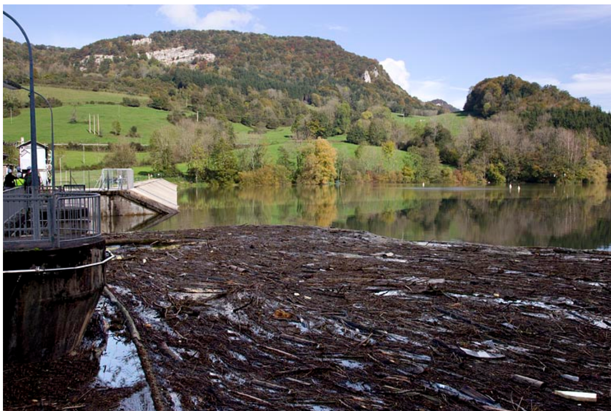
Barrage : amoncellement de branches et détritus en amont.
