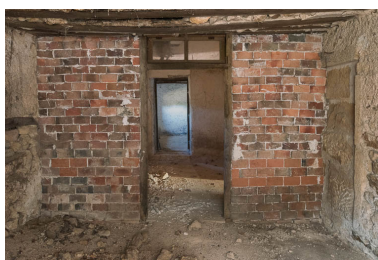
Vue intérieure de l'appentis abritant la bassie (ou arrière-cuisine). Une cloison en briques, ajoutée au XIXe siècle, a amené le bouchage d'une ancienne porte. Phot. Pierre-Marie Barbe-Richaud IVR26_20197100354NUC4A
