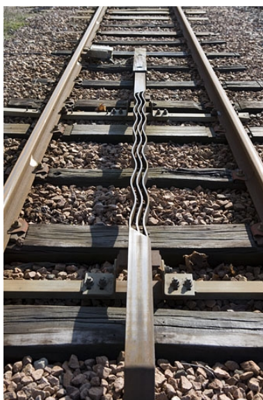
Gare de Champagnole : détecteur de passage (crocodile) Phot. Yves Sancey IVR43_20073900047NUCA
