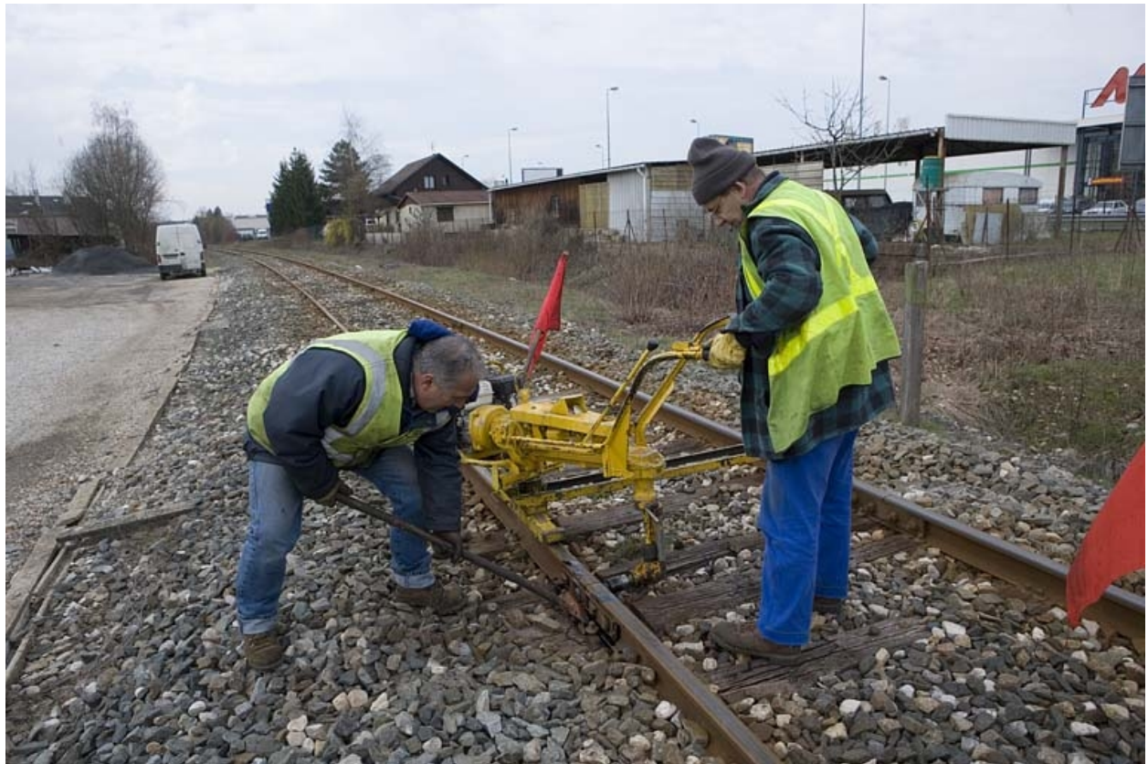
Machine à boulonner et à déboulonner, à visser et à dévisser (tirefonneuse) : utilisation par les agents de l'Équipement.
