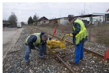
Machine à boulonner et à déboulonner, à visser et à dévisser (tirefonneuse) : utilisation par les agents de l'Équipement. Phot. Yves Sancey IVR43_20070100014NUCA
