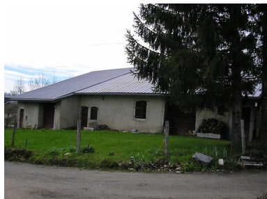
Façade postérieure. Phot. Marie-Pierre Reynet IVR43_20083900180NUC1A
