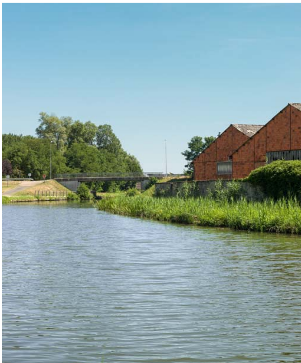
Vue générale du pont et du site.
