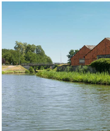
Vue générale du pont et du site. Phot. Pierre-Marie Barbe-Richaud IVR26_20177100244NUC2A
