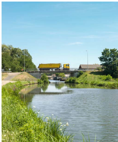
Vue générale du pont. Phot. Pierre-Marie Barbe-Richaud IVR26_20177100243NUC2A
