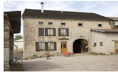
Logement et corps de ferme. Phot. Jérôme Mongreville IVR43_20077000136NUCA
