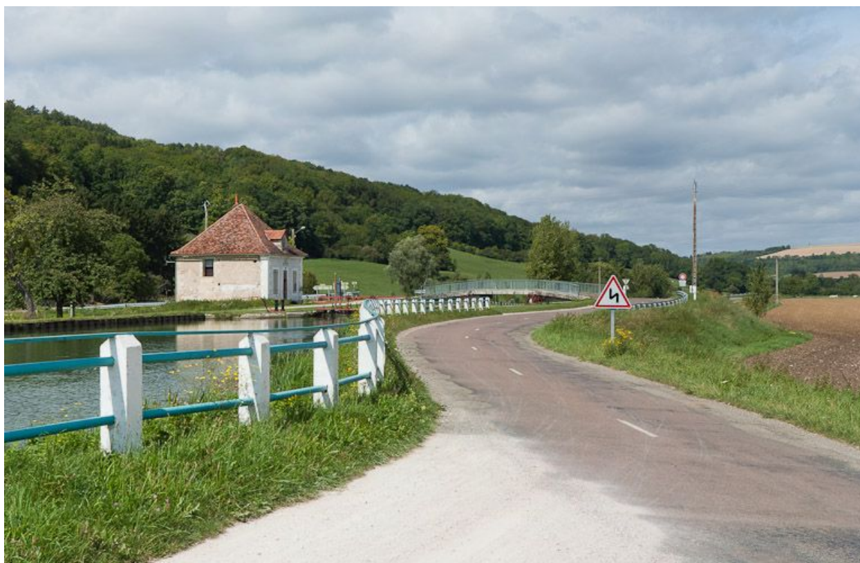
Vue du site d'écluse depuis la route.
