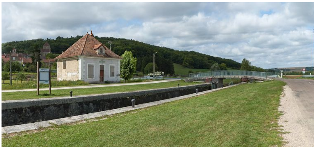
Vue d'ensemble du site d'écluse.
