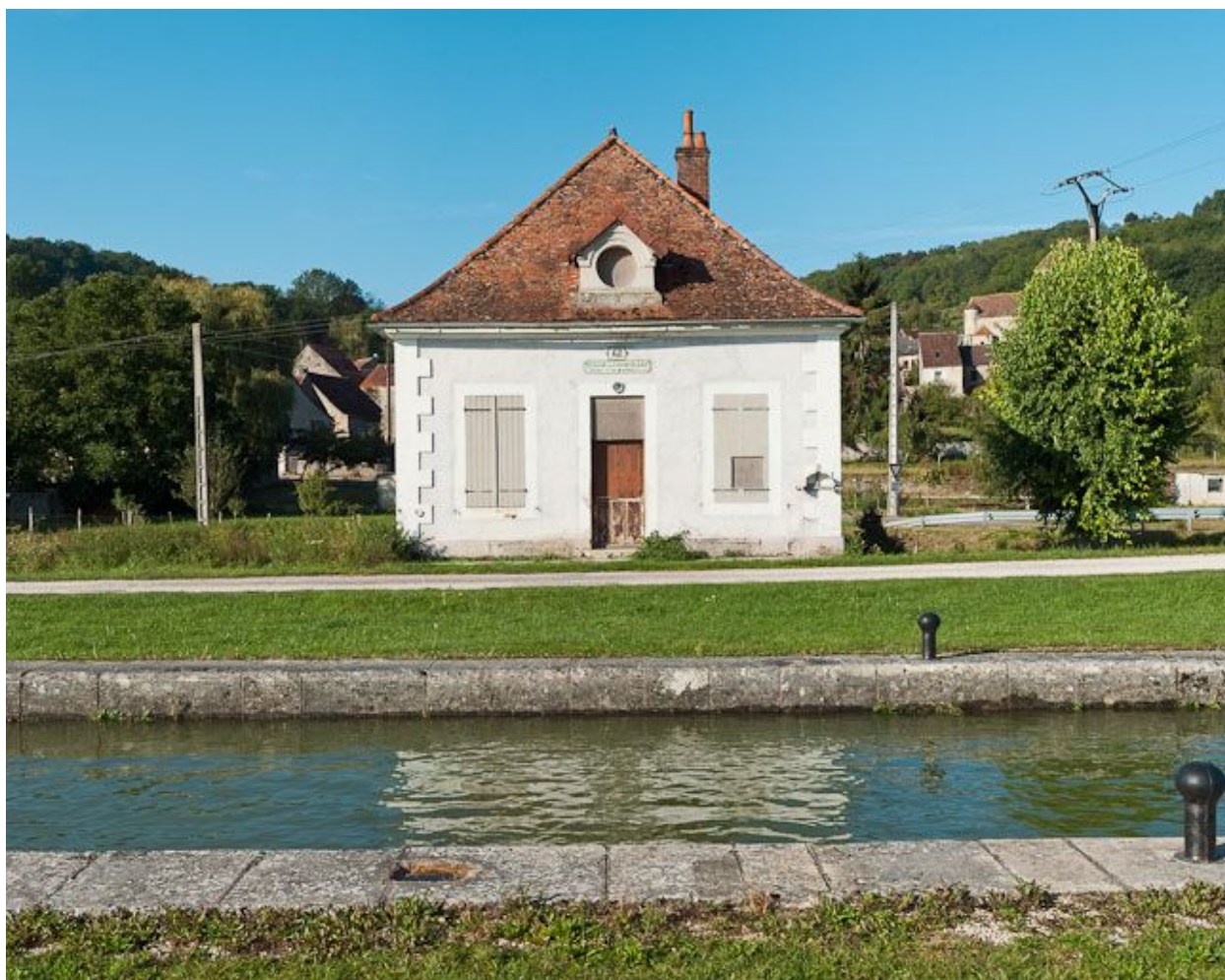
Vue de face de la maison éclusière.
