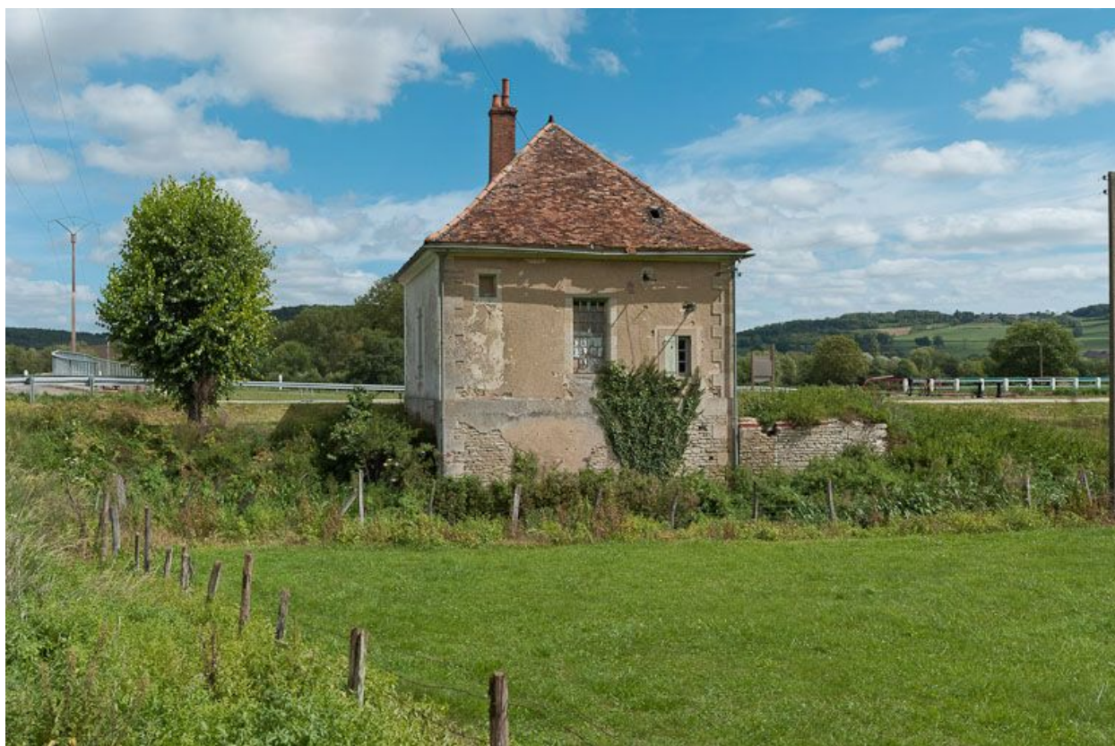
Vue de l'arrière de la maison éclusière.
