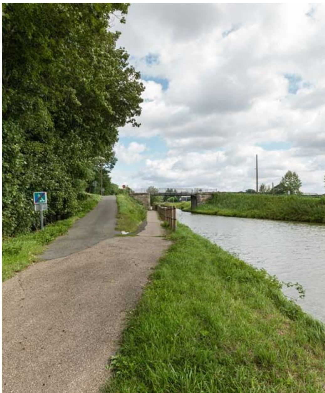
Vue d'ensemble du pont.
