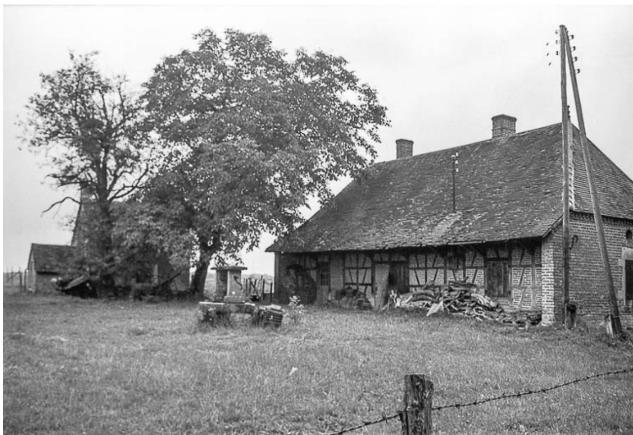
Façade antérieure du bâtiment d'habitation.
