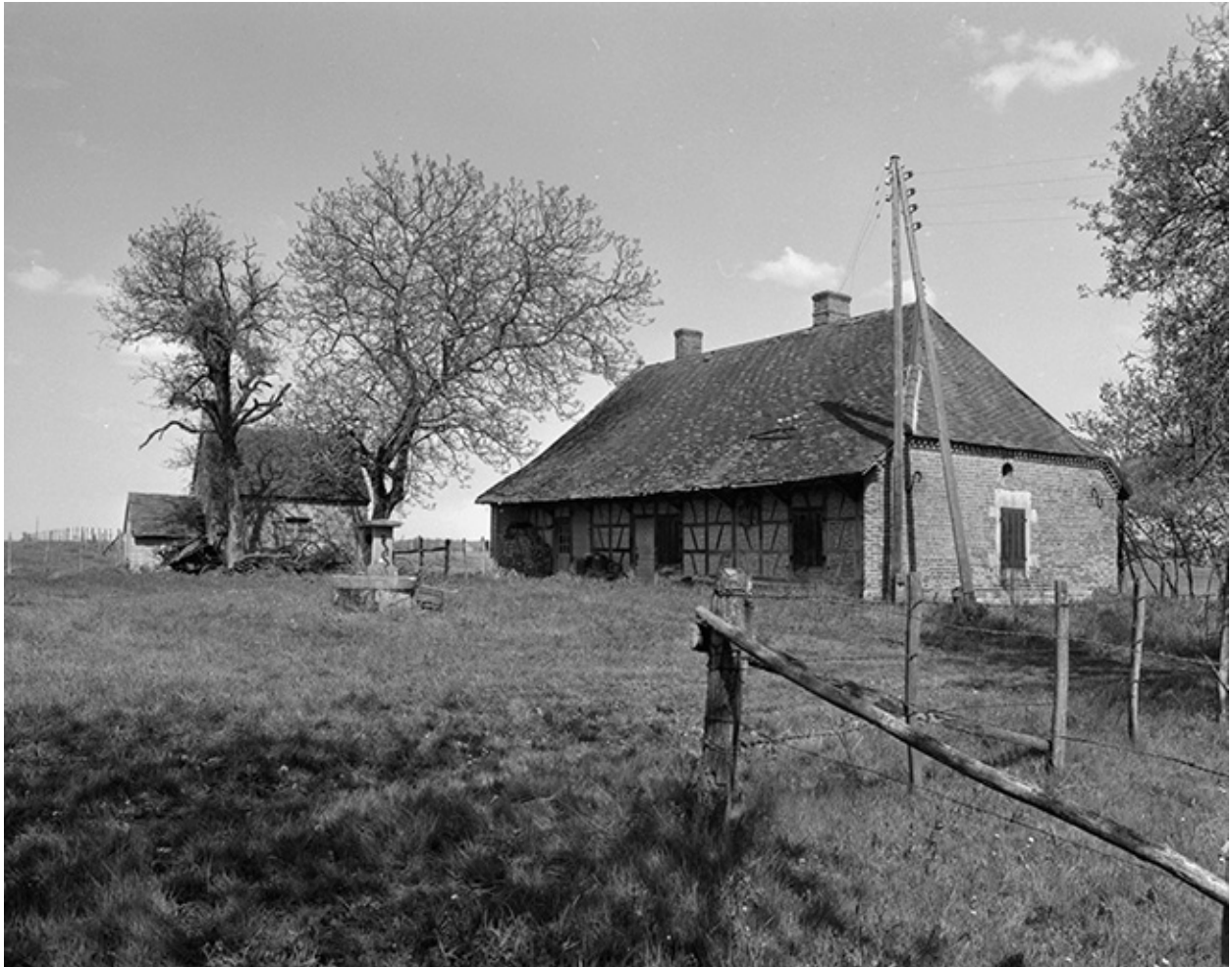
Façade antérieure du bâtiment d'habitation..
